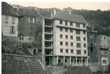
Immeuble en voie d'achèvement, s.d. [vers 1961].
