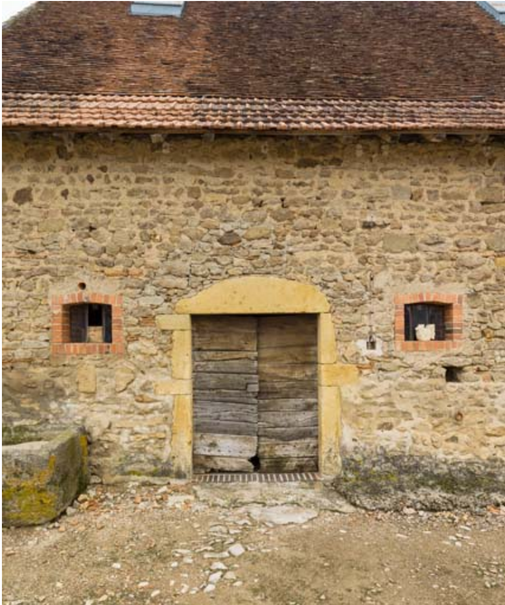
Etable. Détail de la travée ouest.
