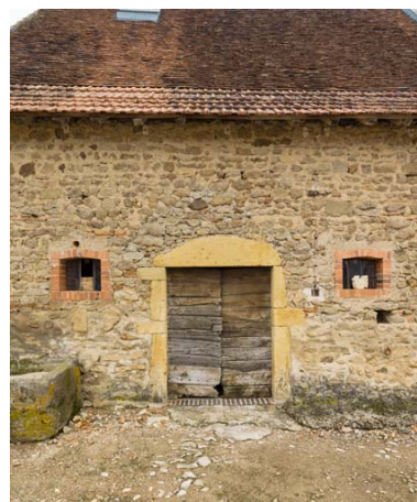
Etable. Détail de la travée ouest. Phot. Pierre-Marie Barbe-Richaud
