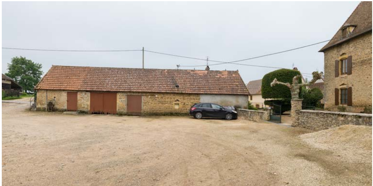
Bâtiment agricole : écurie, remise et bûcher.
