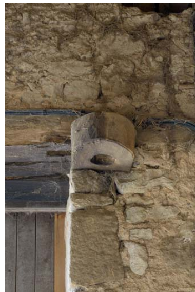
Pierre percée qui recevait l'axe de la porte de l'étable. Phot. Pierre-Marie Barbe-Richaud IVR26_20187100015NUC4A
