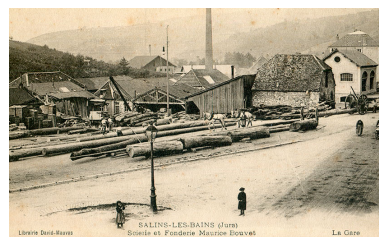
Salins-les-Bains (Jura). Scierie et fonderie Maurice Bouvet, s.d. [fin 19e et début 20e siècle]. Phot. auteur inconnu IVR43_20263900007NUC4A
