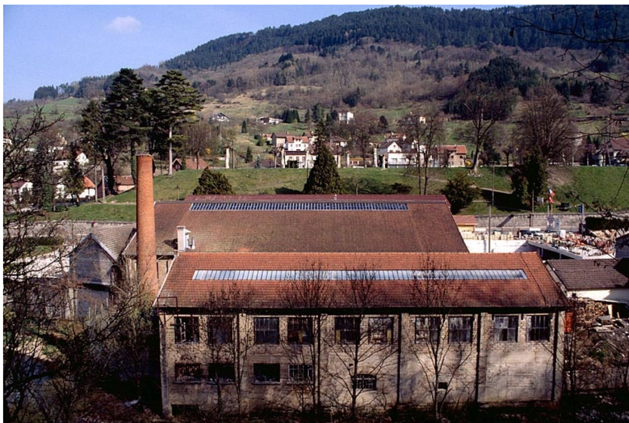
Façade postérieure de l'atelier de mécanique générale.
