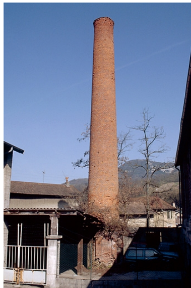
Cheminée. Phot. Yves Sancey IVR43_19973900629ZA
