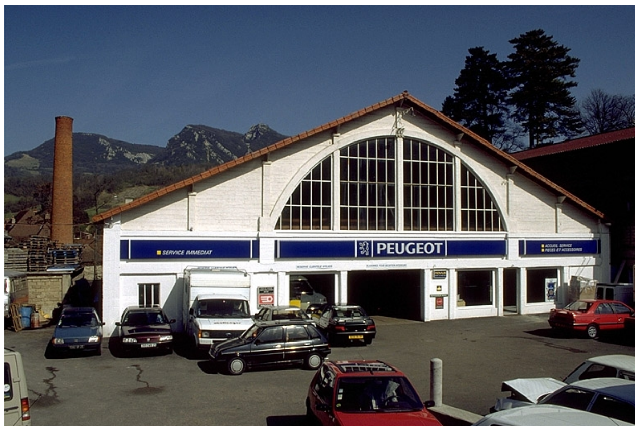
Pignon sud de l'atelier de fabrication.
