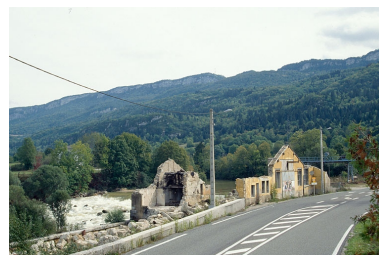
Vestiges, côté route.
