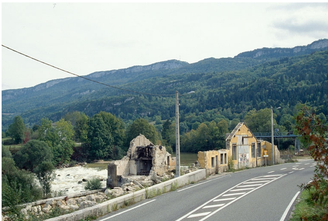
Vestiges, côté route.
