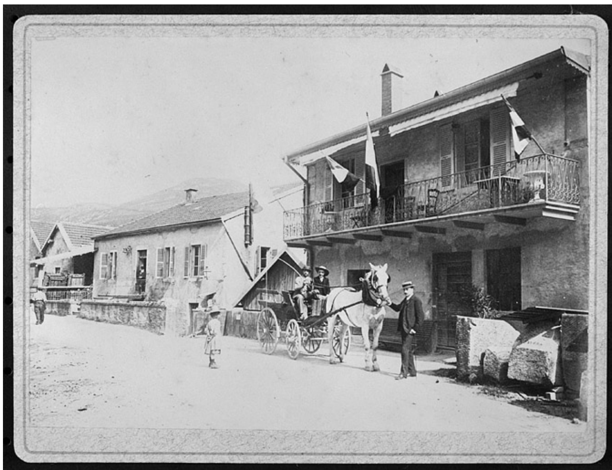
Attelage devant des ateliers et logement.
