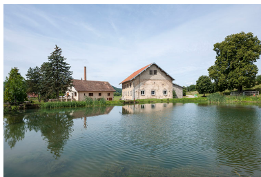
Vue d'ensemble depuis l'étang de retenue. Phot. Jérôme Mongreville IVR43_20152501619NUC4A
