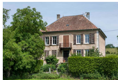
Façade sud du logement. Phot. Jérôme Mongreville IVR43_20152501620NUC4A
