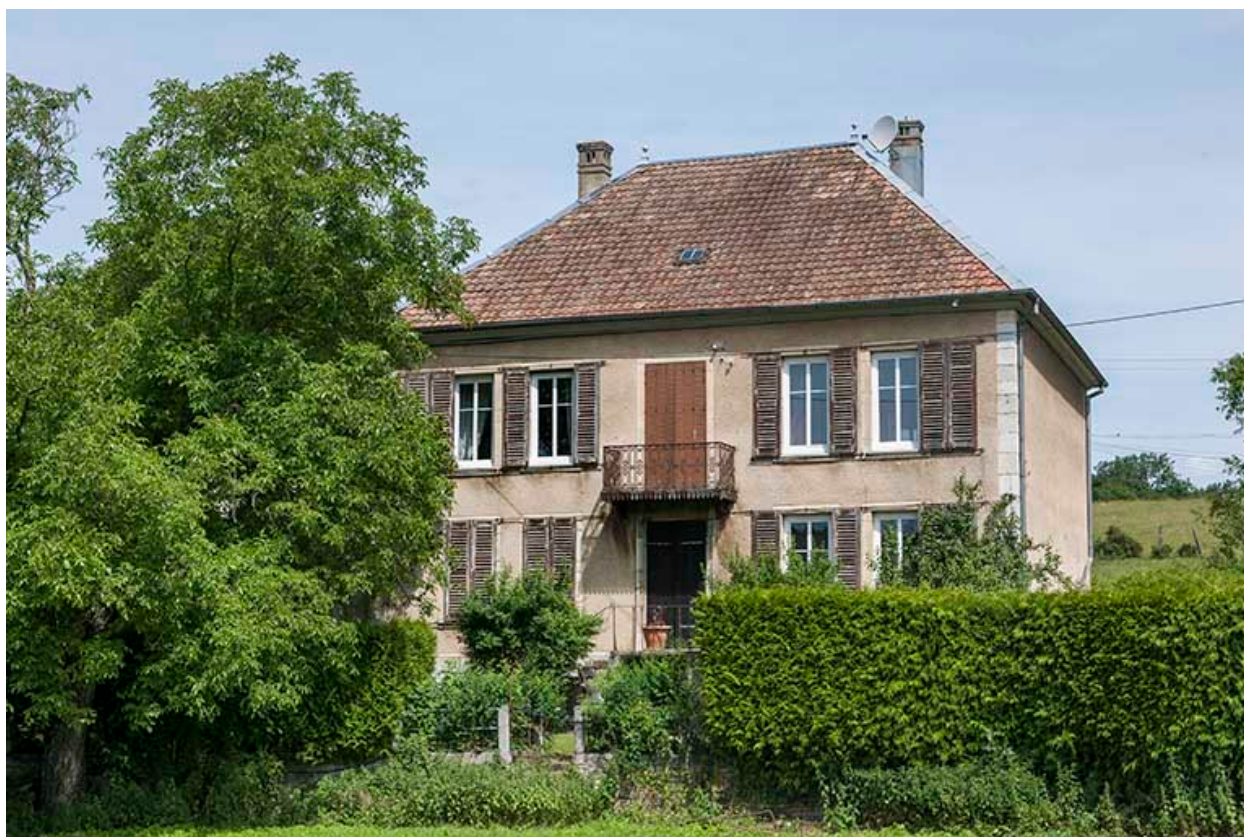
Façade sud du logement.
