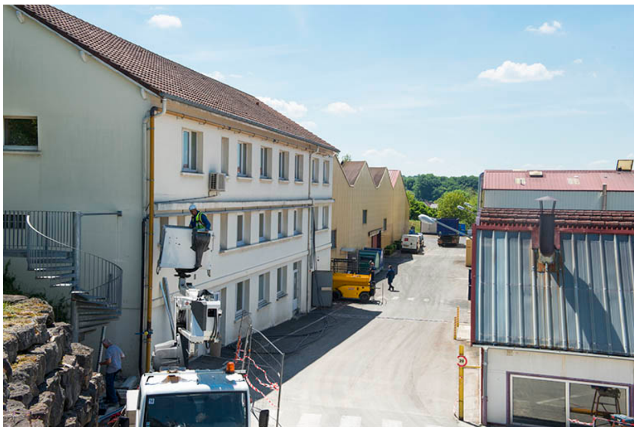
Bâtiment administratif et atelier de fabrication.
