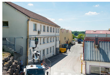
Bâtiment administratif et atelier de fabrication. Phot. Mary Ruffinoni IVR43_20132500624NUC4A
