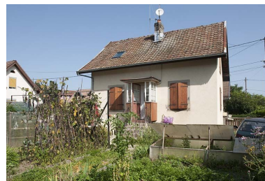
Maison individuelle rue des Lesses. Façade postérieure. Phot. Jérôme Mongreville IVR43_20112502243NUC4A
