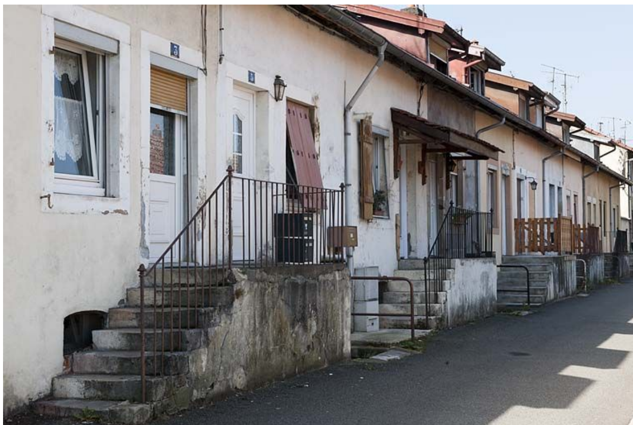
Façade nord sur la rue des Cités.
