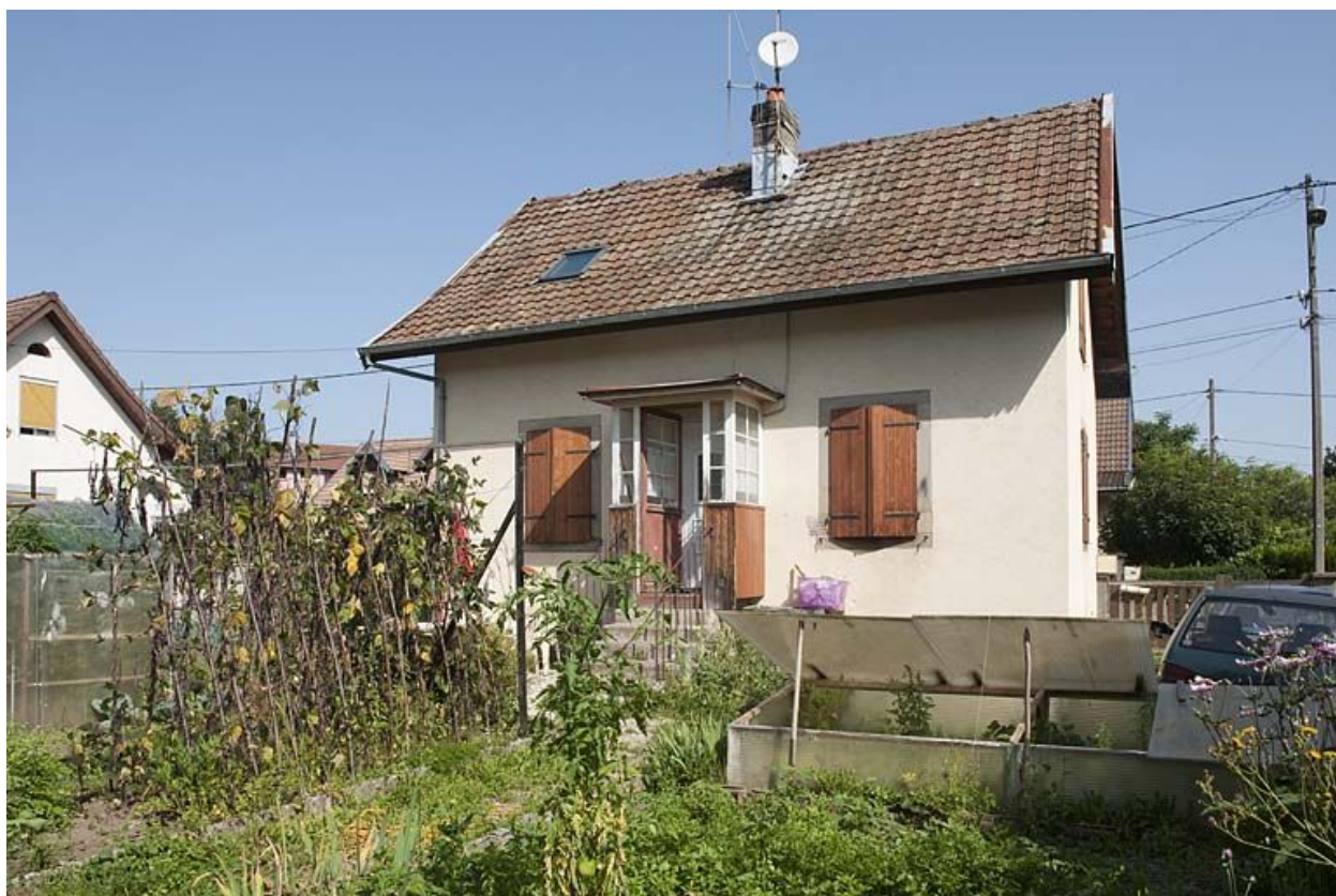
Maison individuelle rue des Lesses. Façade postérieure.
