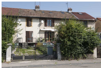
Elévation de la façade sud. Phot. Jérôme Mongreville IVR43_20112502245NUC4A
