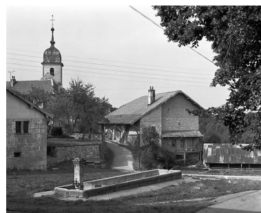
Ferme située place de l'Eglise. Phot. Yves Sancey IVR43_19802500879X
