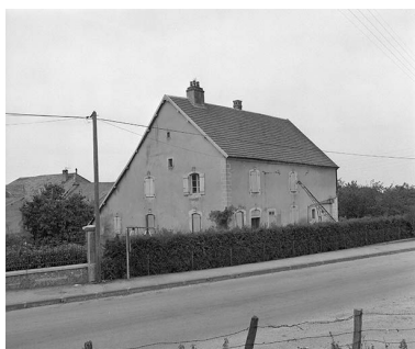
Maison située rue des Fontaines.
