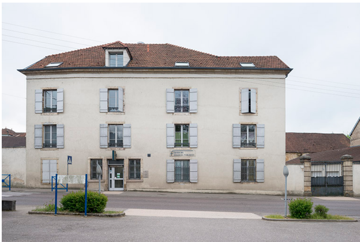
Vue générale du bâtiment.
