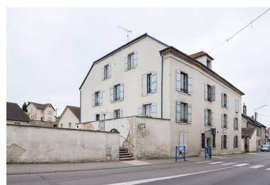
Vue depuis le haut de la rue F. Mitterrand. Phot. Jérôme Mongreville IVR43_20177000720NUC4A
