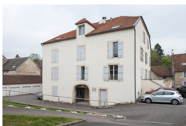
Façade postérieure. Phot. Jérôme Mongreville IVR43_20177000722NUC4A
