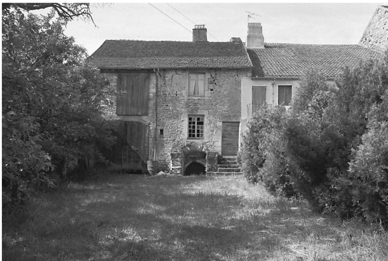
Façade antérieure sur cour.
