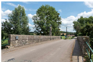
Vue d'ensemble du pont et de la statue Phot. Sonia Dourlot IVR43_20167001125NUC4A
