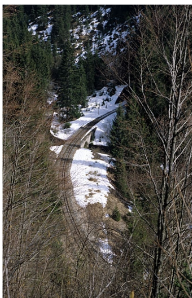
2 ponts ferroviaires (voie ferrée Andelot - La Cluse) situé au lieudit Le Caton. Phot. Yves Sancey IVR43_20053900380ZA
