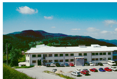
Façade latérale de l'aile nord. Phot. Laurent Poupard IVR43_19913901562ZA
