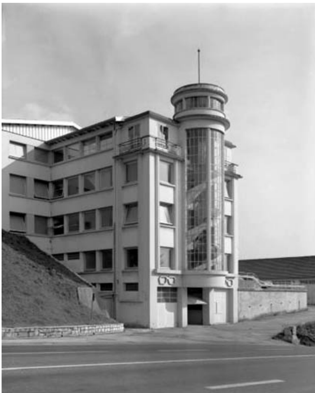
Cage d'escalier demi-hors-oeuvre.
