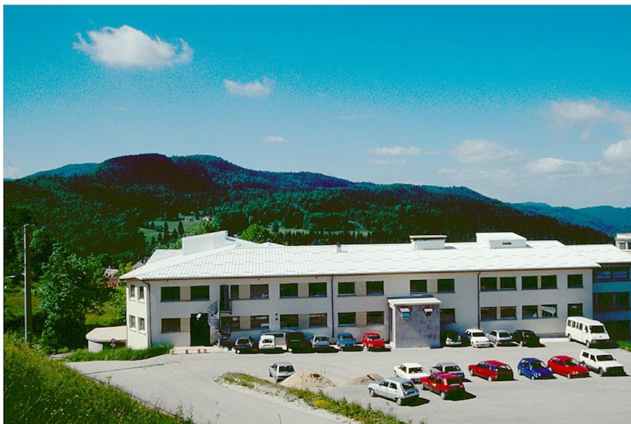
Façade latérale de l'aile nord.
