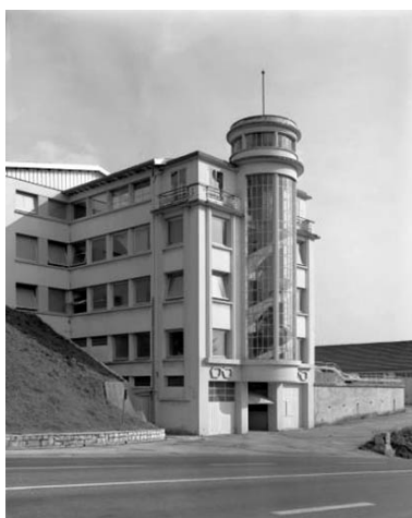
Cage d'escalier demi-hors-oeuvre.
