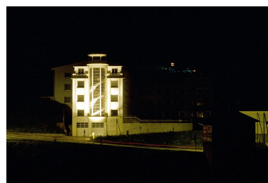
Cage d'escalier demi- hors-oeuvre, de nuit.
