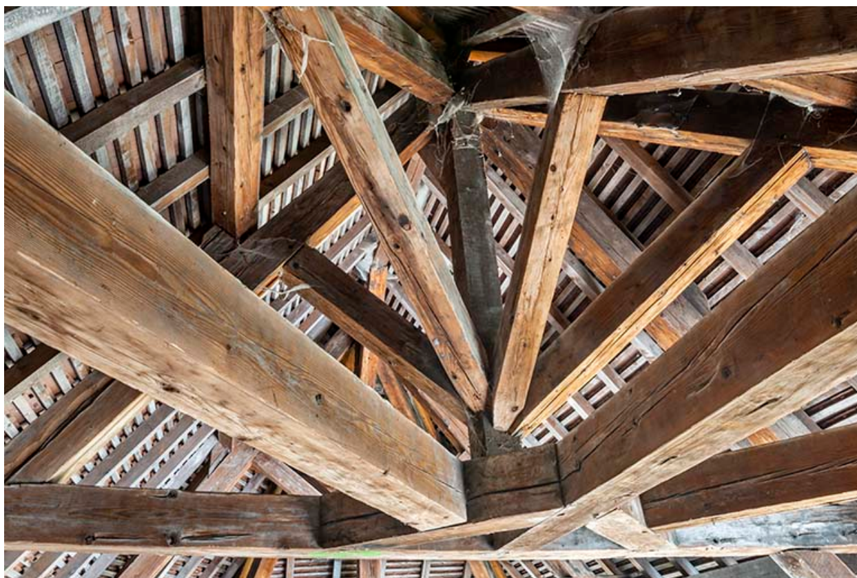
Charpente. Détail de l'enrayure sud.
