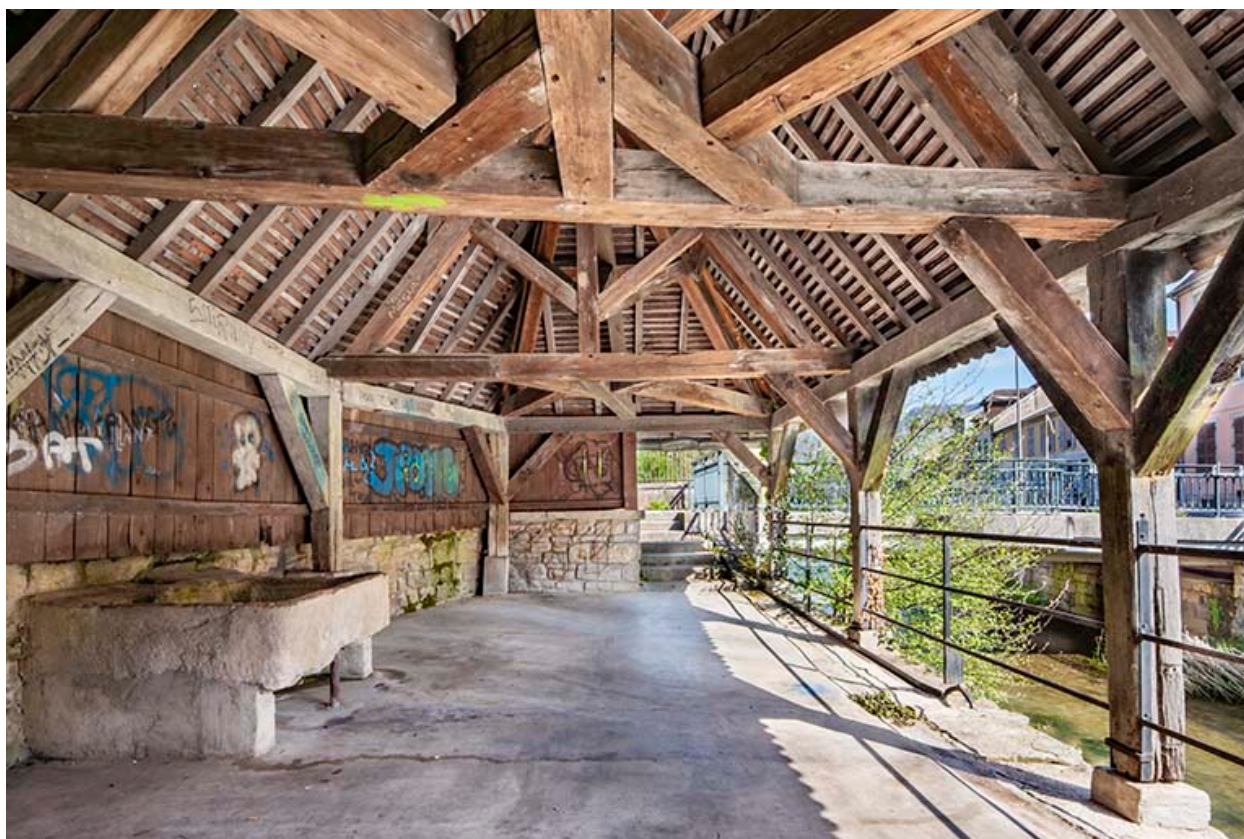
Vue de la charpente, depuis le sud.
