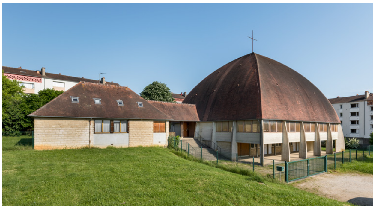
Centre paroissial. Vue d'ensemble.
