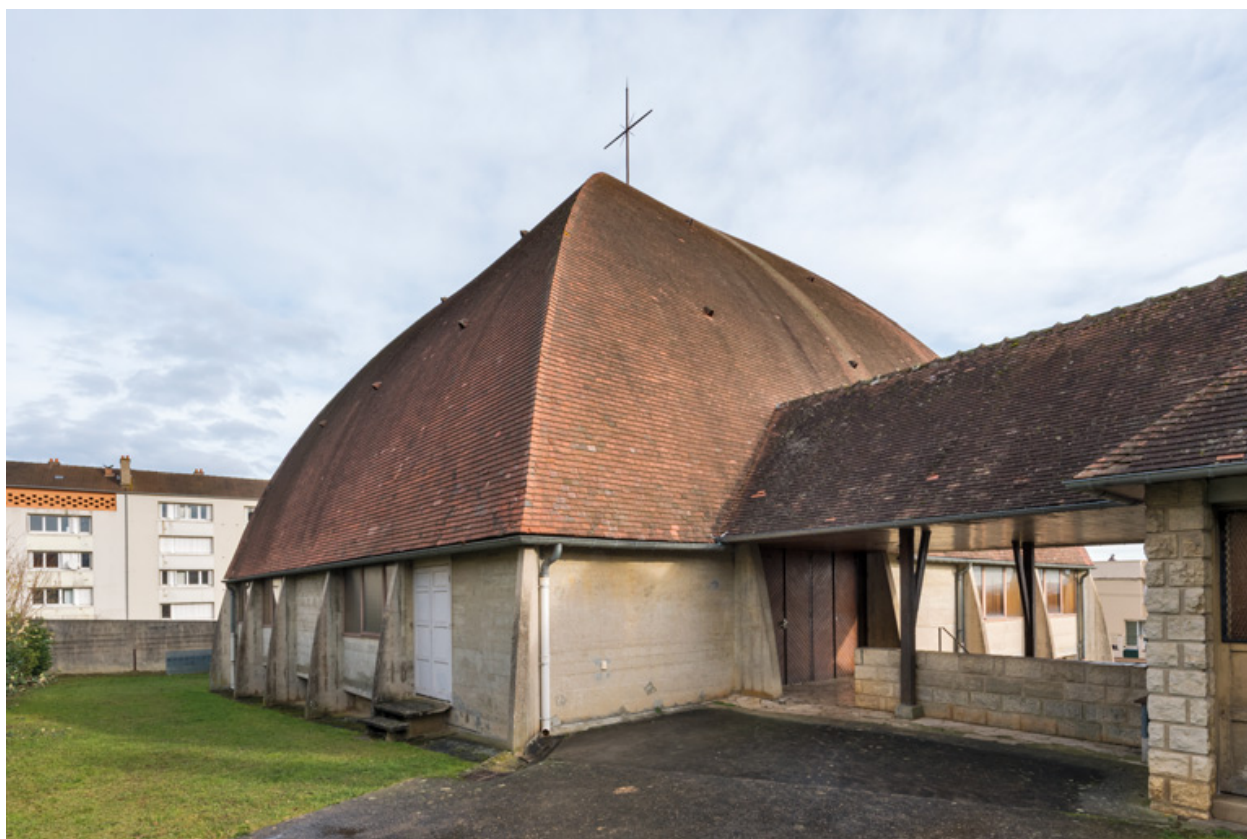
Eglise. Vue de trois quarts depuis l'est.
