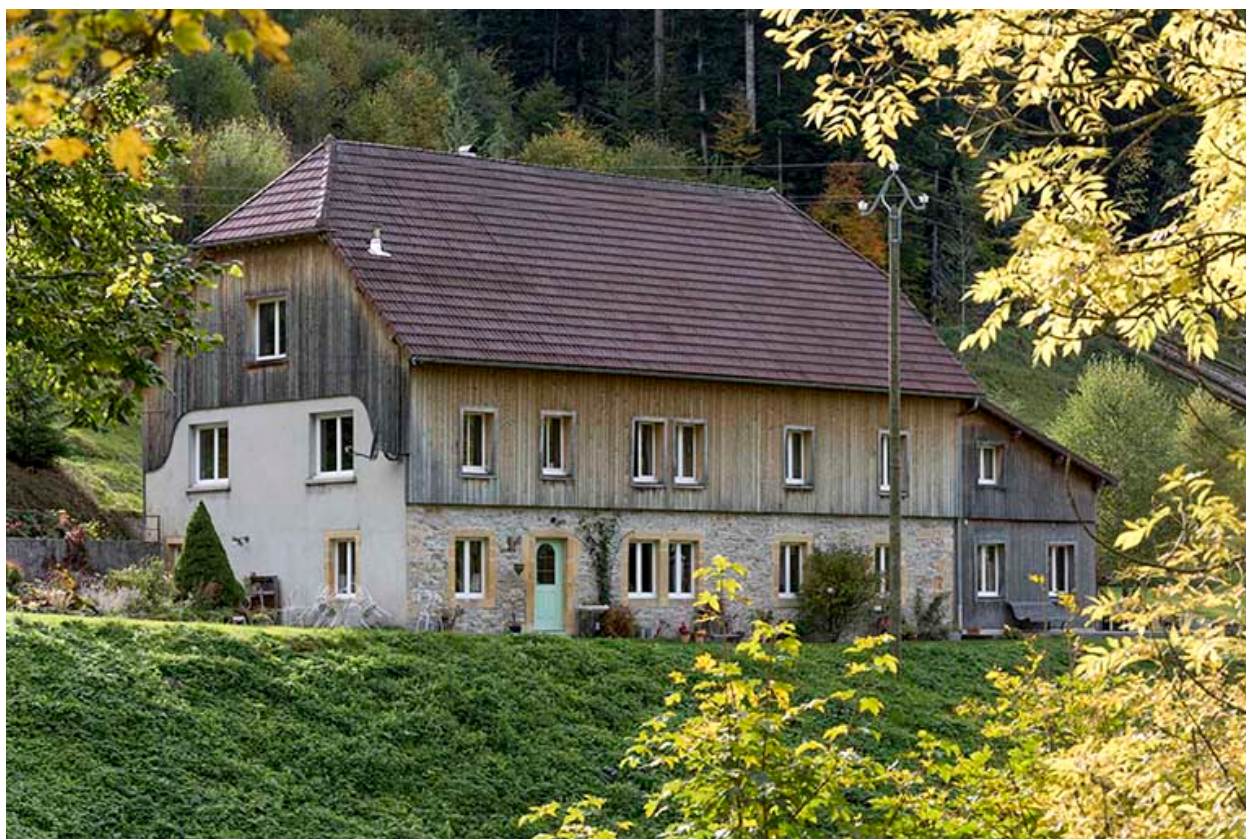
Façades nord et est.
