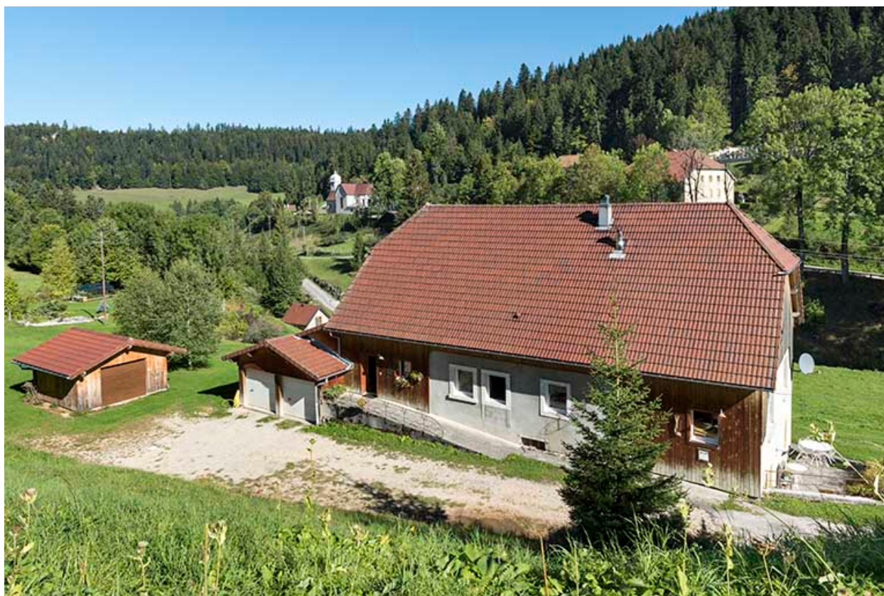
Vue plongeante sur la façade sud.
