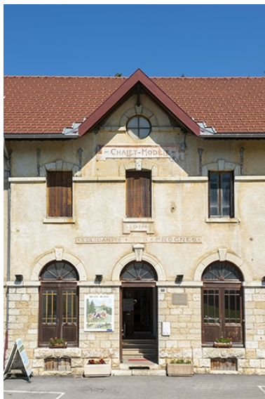
Partie centrale de la façade antérieure. Phot. Jérôme Mongreville IVR43_20203900081NUC4A
