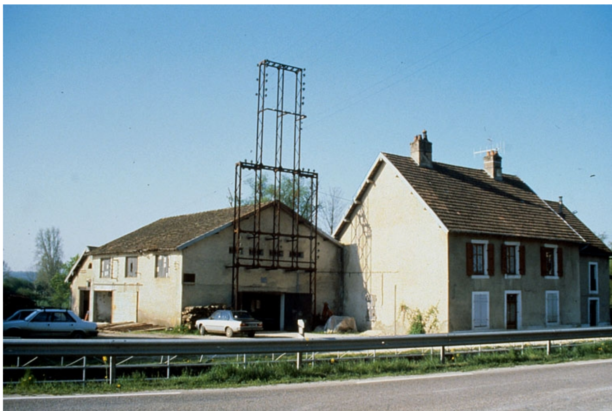
Centrale et maison vues du nord.
