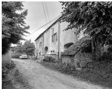
Façade antérieure vue de trois-quarts droit. Phot. Yves Sancey IVR43_19813900020X
