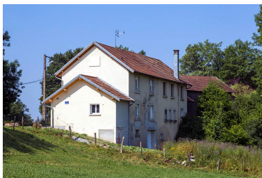
Façades postérieure et latérale droite.
