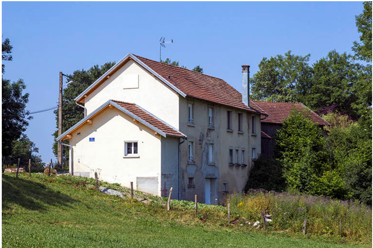
Façades postérieure et latérale droite.
