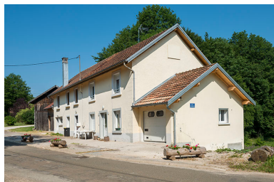
Façades antérieure et latérale droite.
