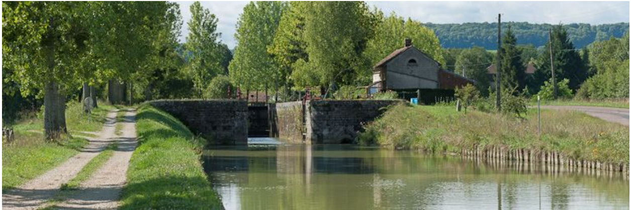
Vue du site d'écluse depuis l'aval.
