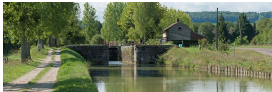
Vue du site d'écluse depuis l'aval. Phot. Pierre-Marie Barbe-Richaud IVR26_20112103830NUC4AQ
