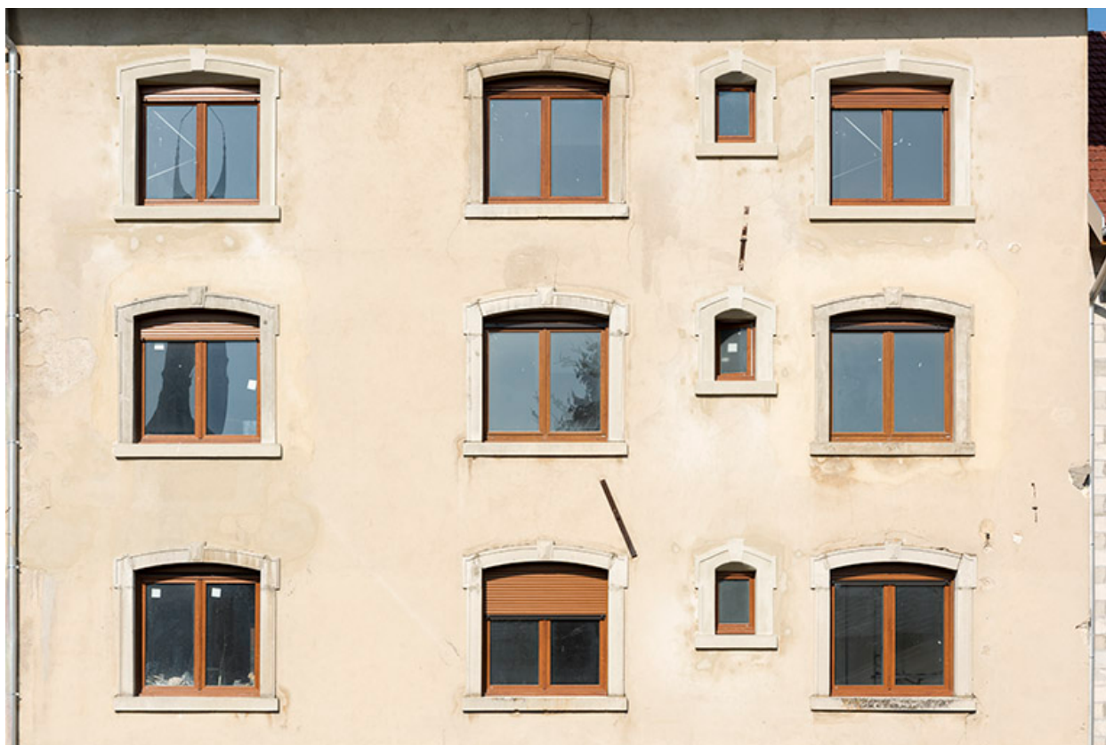
Façade postérieure : fenêtres.
