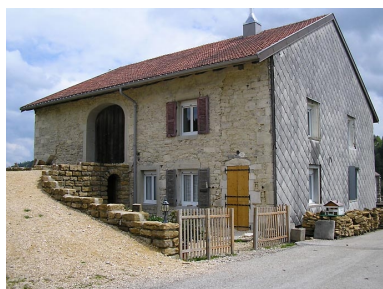
Ferme située 7 rue de la Chapelle. Phot. Marie-Pierre Reynet IVR43_20083900353NUC1A
