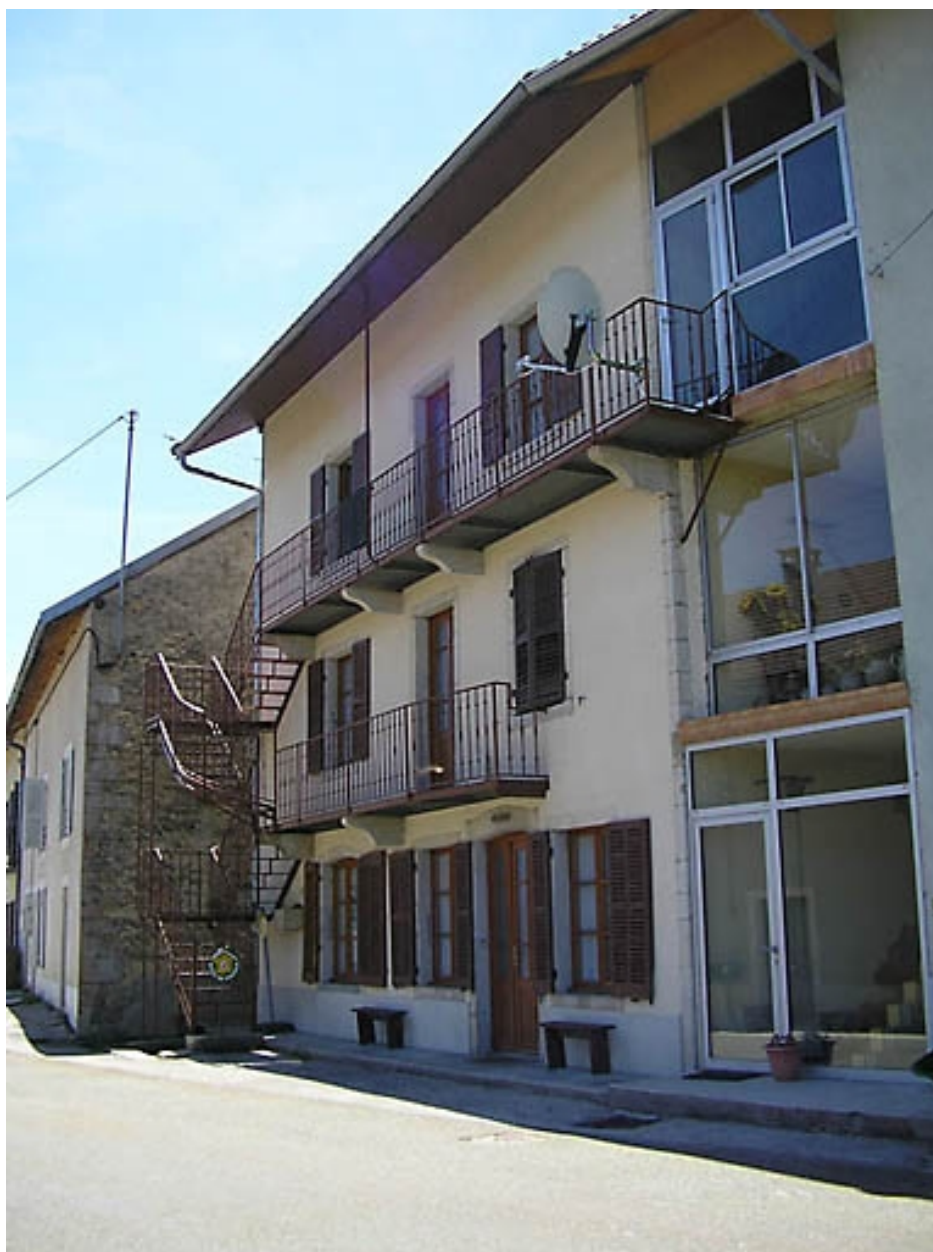
Maison située 10 rue du Haut.
