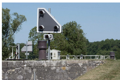
Détail du système d'automatisation de l'écluse : les feux de signalisation. Phot. Thierry Kuntz IVR26_20112103080NUC2A
