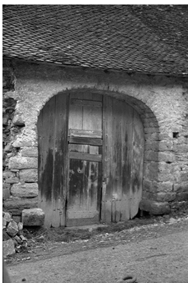
Ferme cadastrée 1965 AD : porte de grange. Phot. F. Pernin IVR43_19743900062Z
