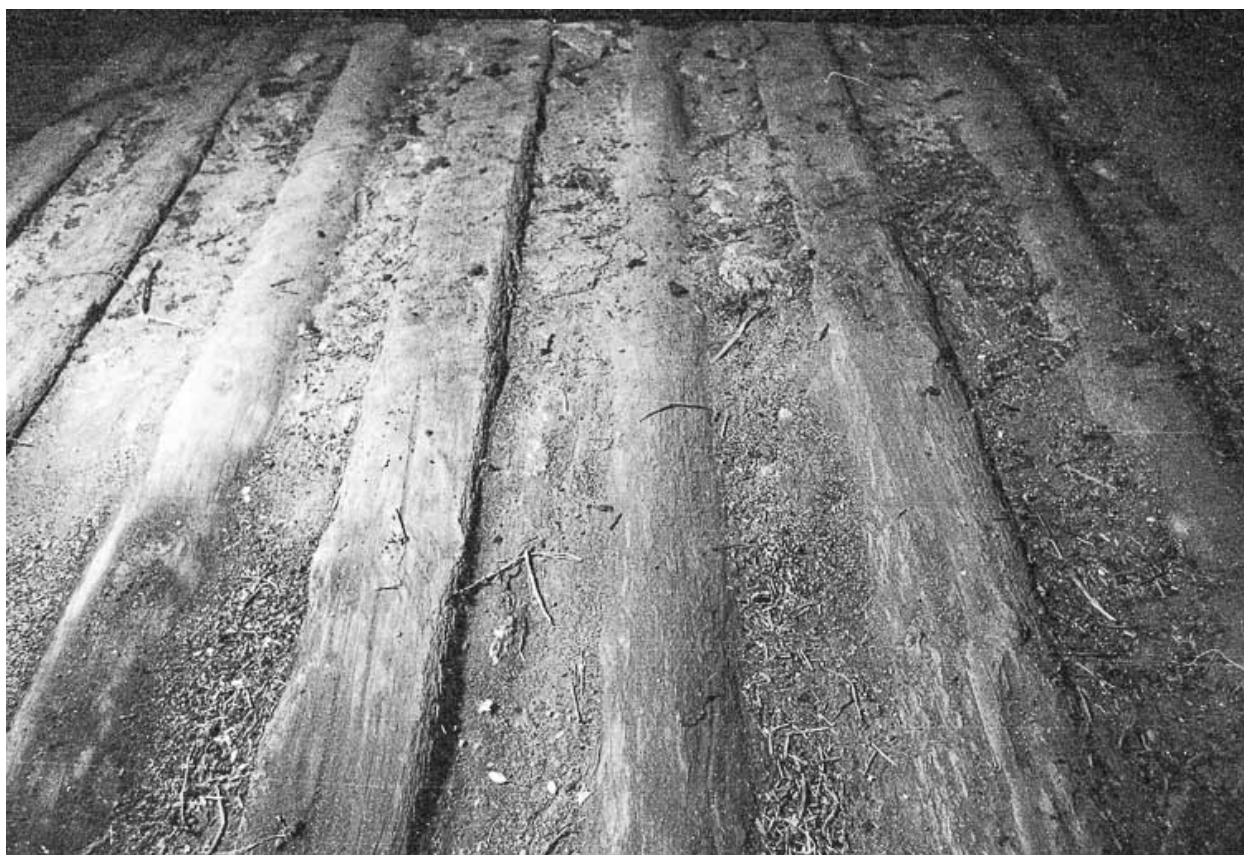
Ferme cadastrée 1965 AD : détail du plafond.
