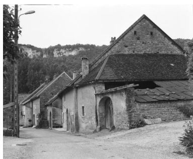
Ferme située rue du Moulin : vue d'ensemble. Phot. Yves Sancey IVR43_19813900213X
