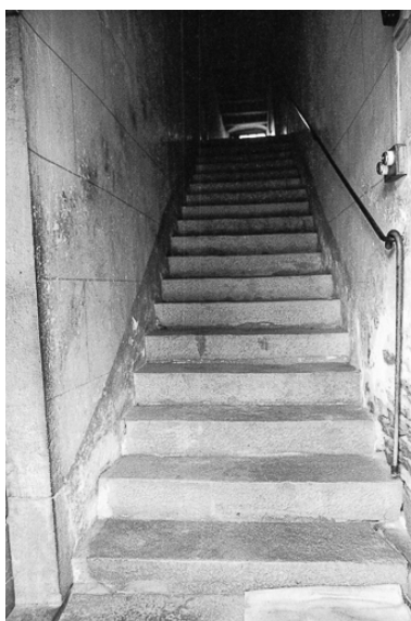
Ferme cadastrée 1965 AD : escalier intérieur. Phot. F. Pernin IVR43_19743900041Z
