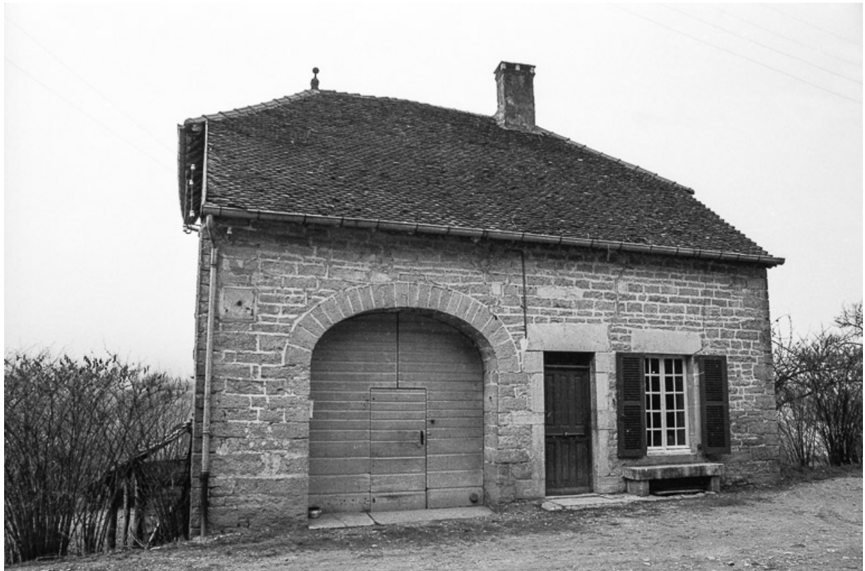
Ferme cadastrée 1965 AD 119 : façade antérieure.
