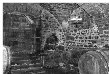
Ferme cadastrée 1965 AD : la cave Phot. F. Pernin IVR43_19743900060Z
