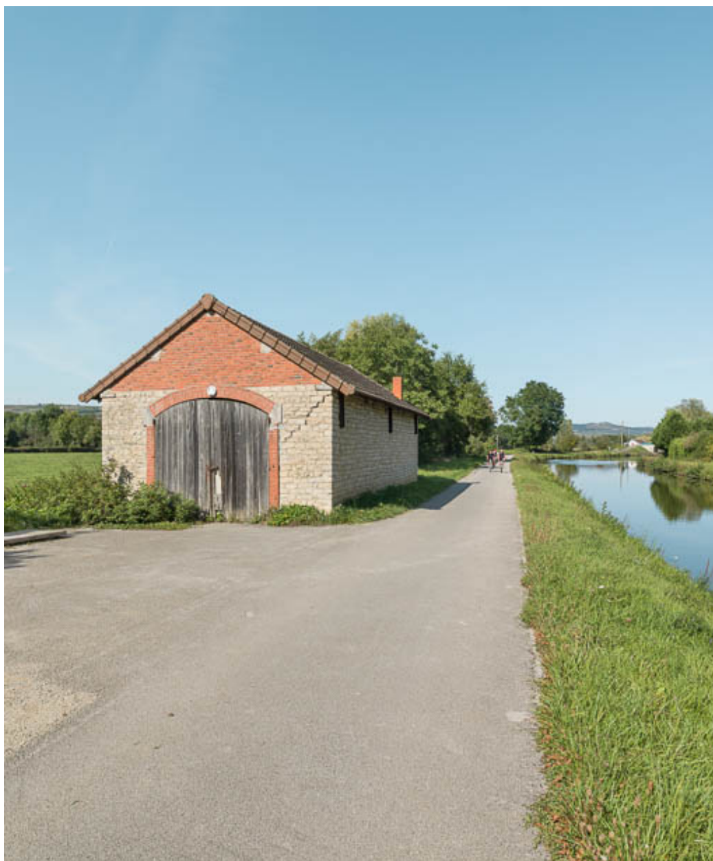
Vue d'ensemble de la remise, rive gauche.
