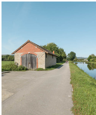
Vue d'ensemble de la remise, rive gauche.
