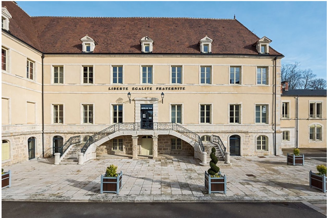
Aile est : façade antérieure.
