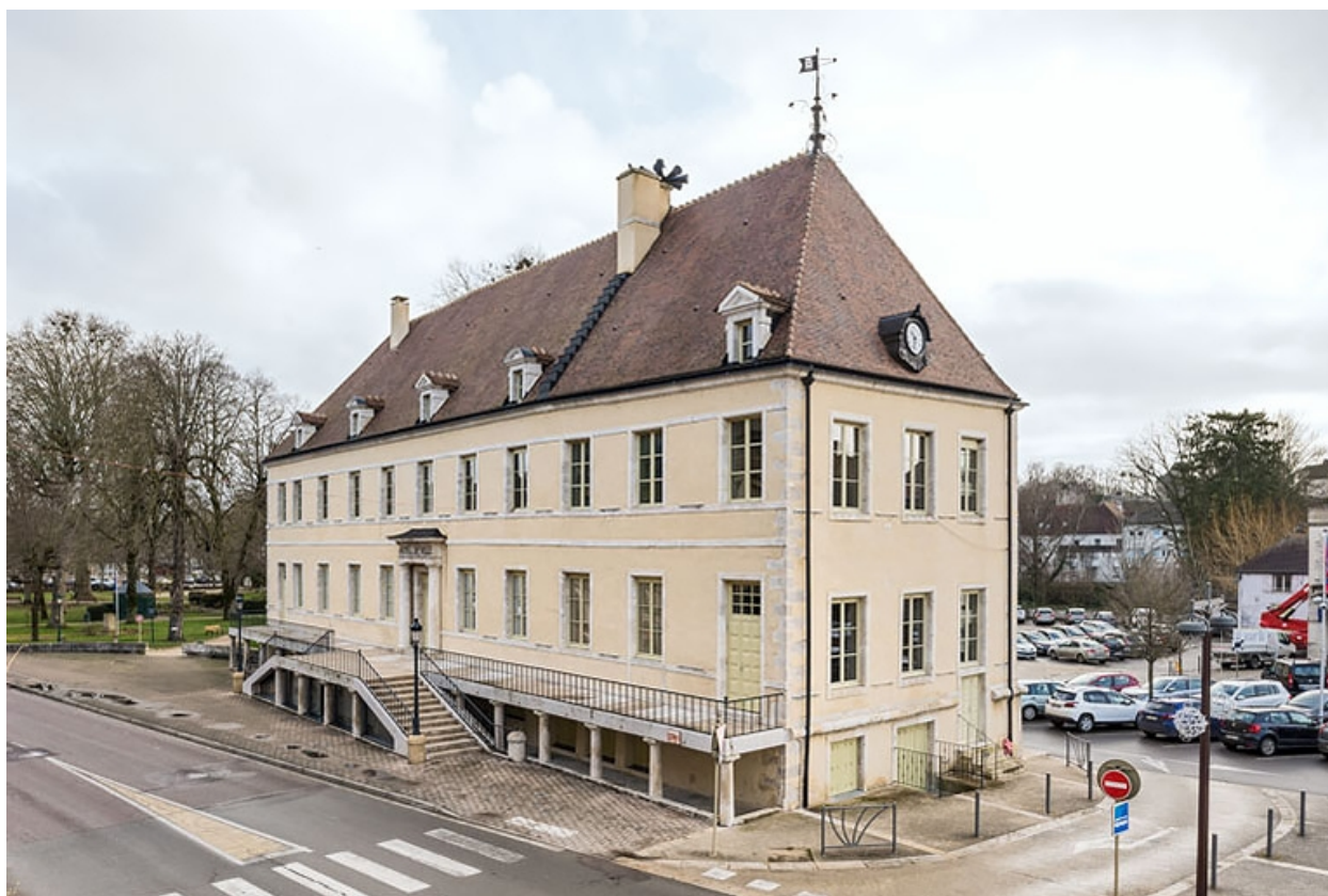
Vue d'ensemble, depuis l'ouest : aile nord.
