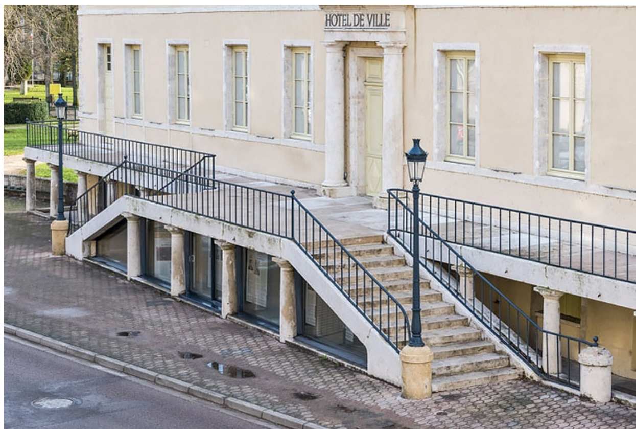
Aile nord, façade antérieure : escalier.
