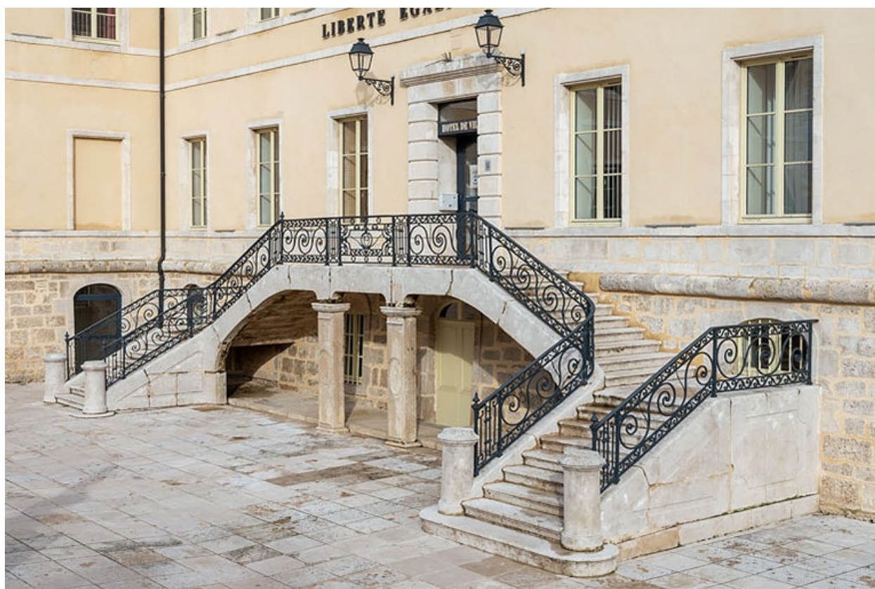
Aile est, façade antérieure : escalier.
