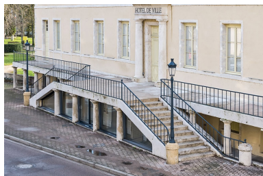
Aile nord, façade antérieure : escalier.
