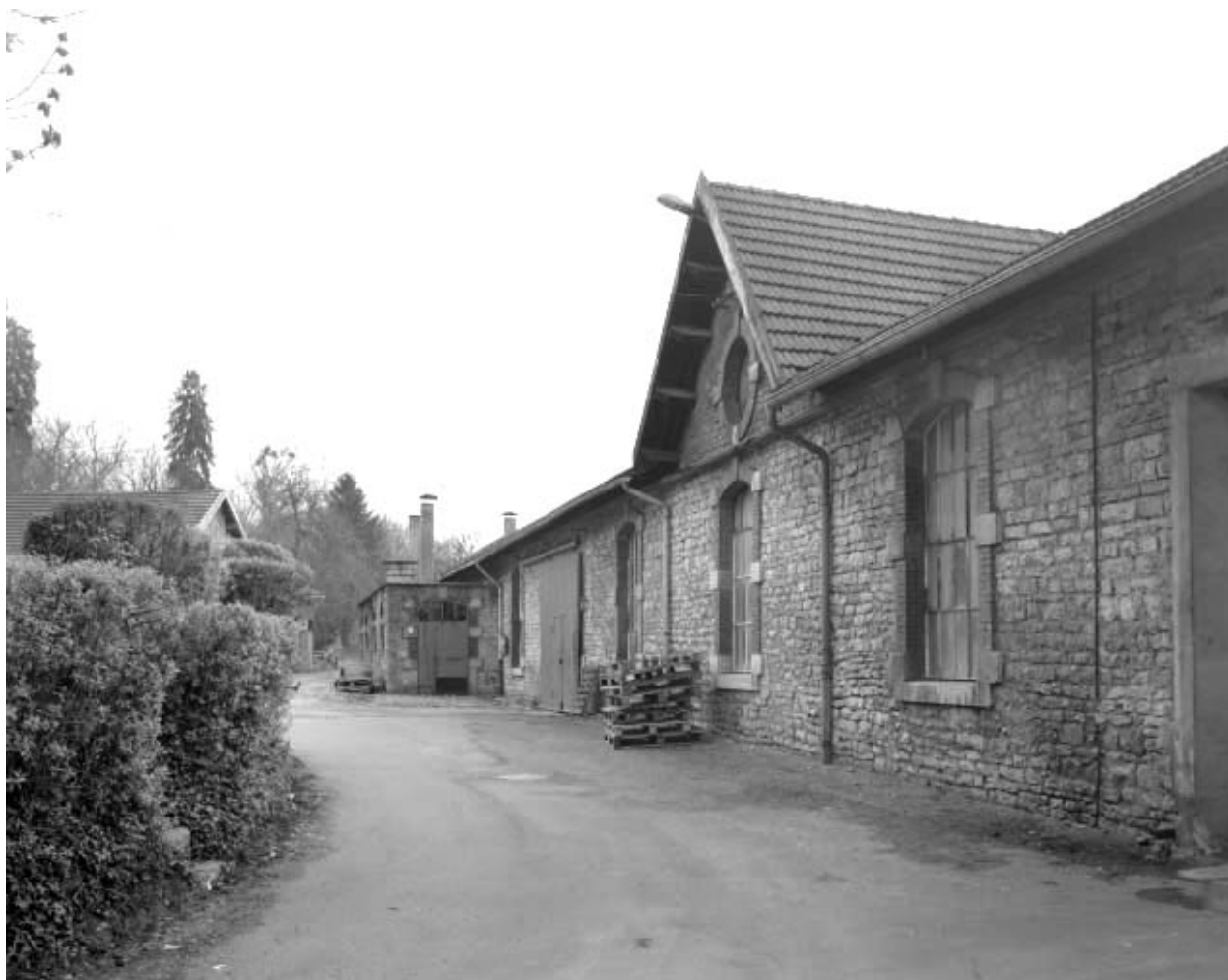
Ateliers de fabrication ouest.
