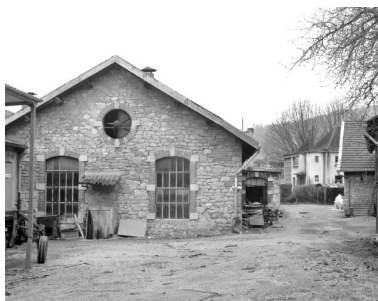
Pignon sud d'un atelier de fabrication. Phot. Jérôme Mongreville IVR43_19973900506X
