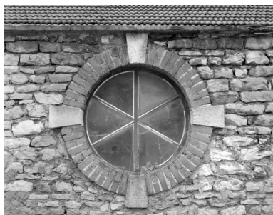
Atelier de fabrication ouest : détail d'un oculus. Phot. Jérôme Mongreville IVR43_19973900508X
