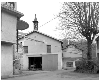
Atelier de fabrication et chaufferie. Phot. Jérôme Mongreville IVR43_19973900500X
