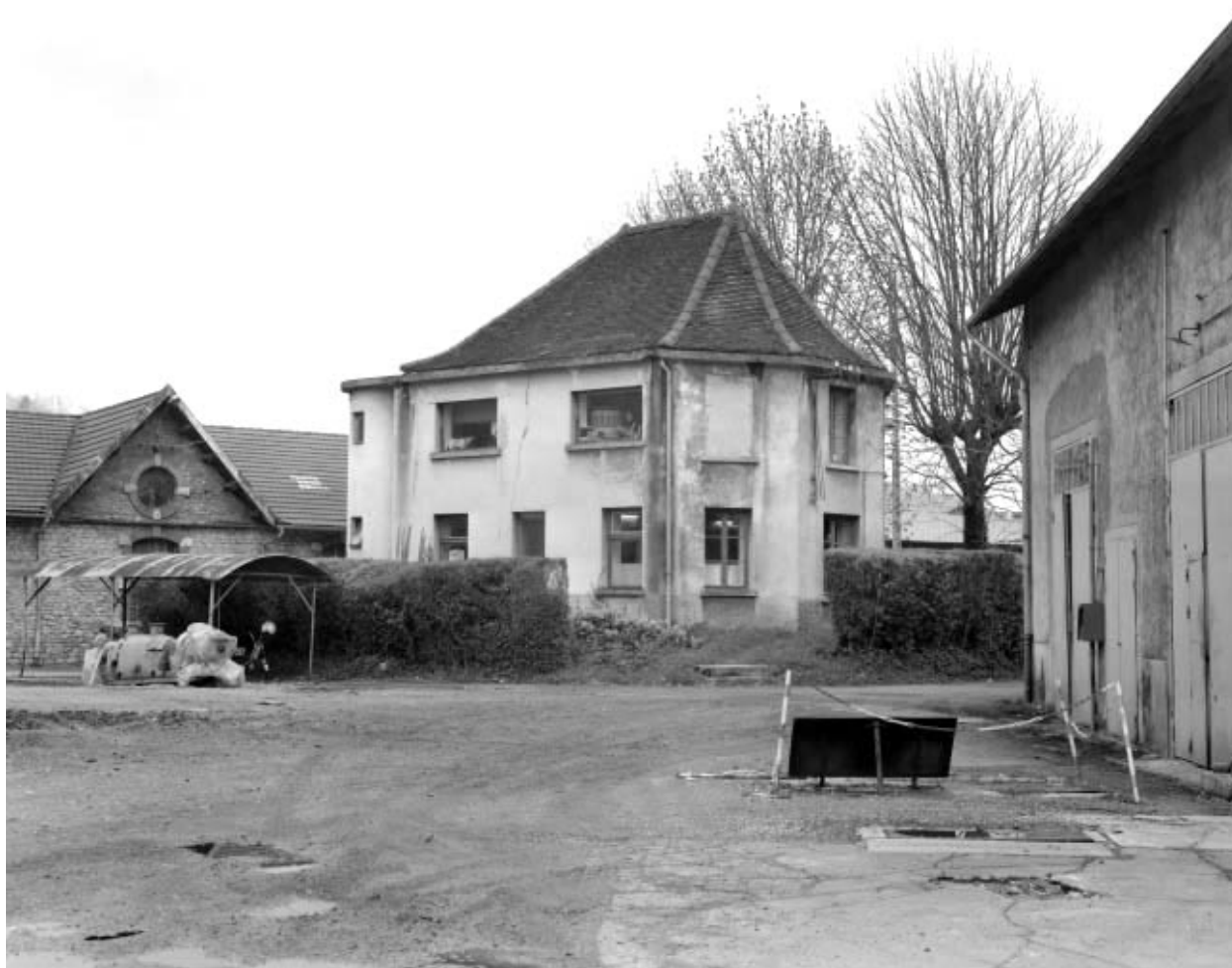
Façade postérieure des bureaux.
