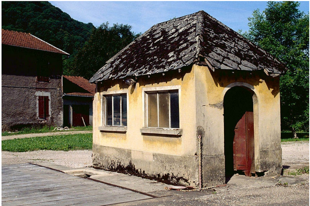
Poste du pont bascule.
