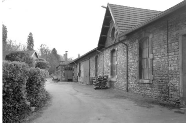
Ateliers de fabrication ouest. Phot. Jérôme Mongreville IVR43_19973900505X
