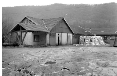
Magasin industriel (déchets de cuir). Phot. Jérôme Mongreville IVR43_19973900498X
