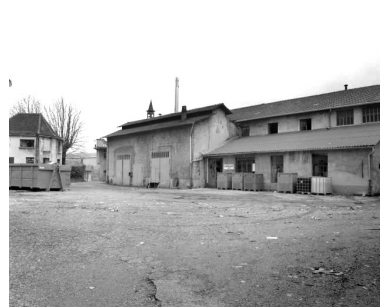
Vue de la seconde cour. De gauche à droite : bureaux, chaufferie et laboratoire. Phot. Jérôme Mongreville IVR43_19973900499X
