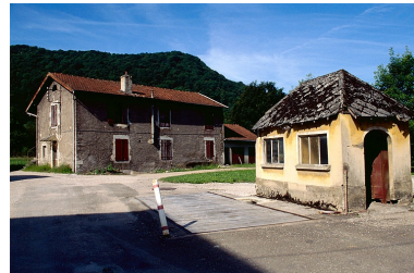
Logement d'ouvriers et pont bascule. Phot. Jérôme Mongreville IVR43_19973901076ZA
