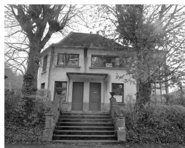
Les bureaux. Phot. Jérôme Mongreville IVR43_19973900489X
