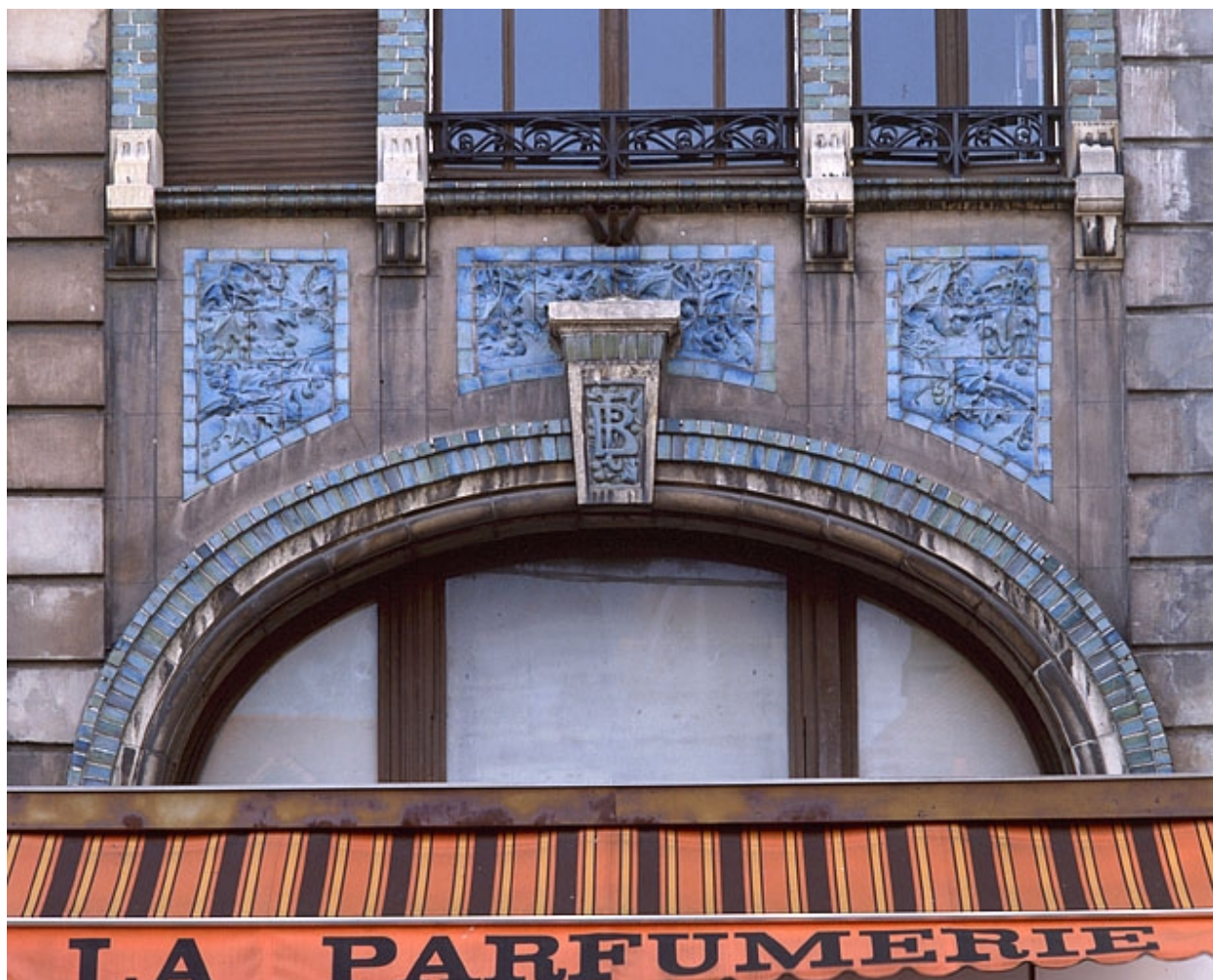
Façade sur la rue Cuvier, détail.
