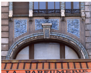
Façade sur la rue Cuvier, détail. Phot. Jérôme Mongreville IVR43_19872500475XA
