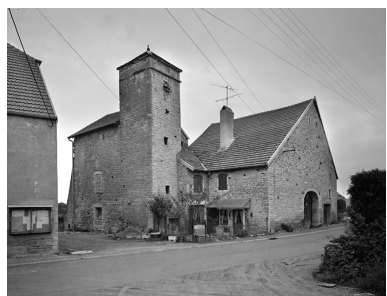
Ferme située 18 route de Valay. Phot. Yves Sancey IVR43_19857000006V
