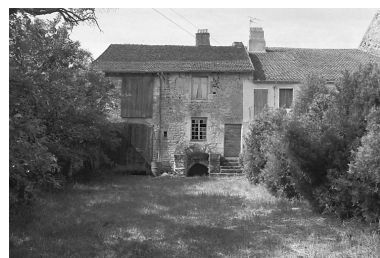
Ferme située route de Pesmes. Phot. Bernard Lardière IVR43_19817000309Z
