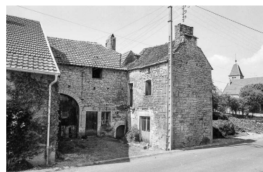
Ferme située 30 route de Bard. Phot. Bernard Lardière IVR43_19817000305Z
