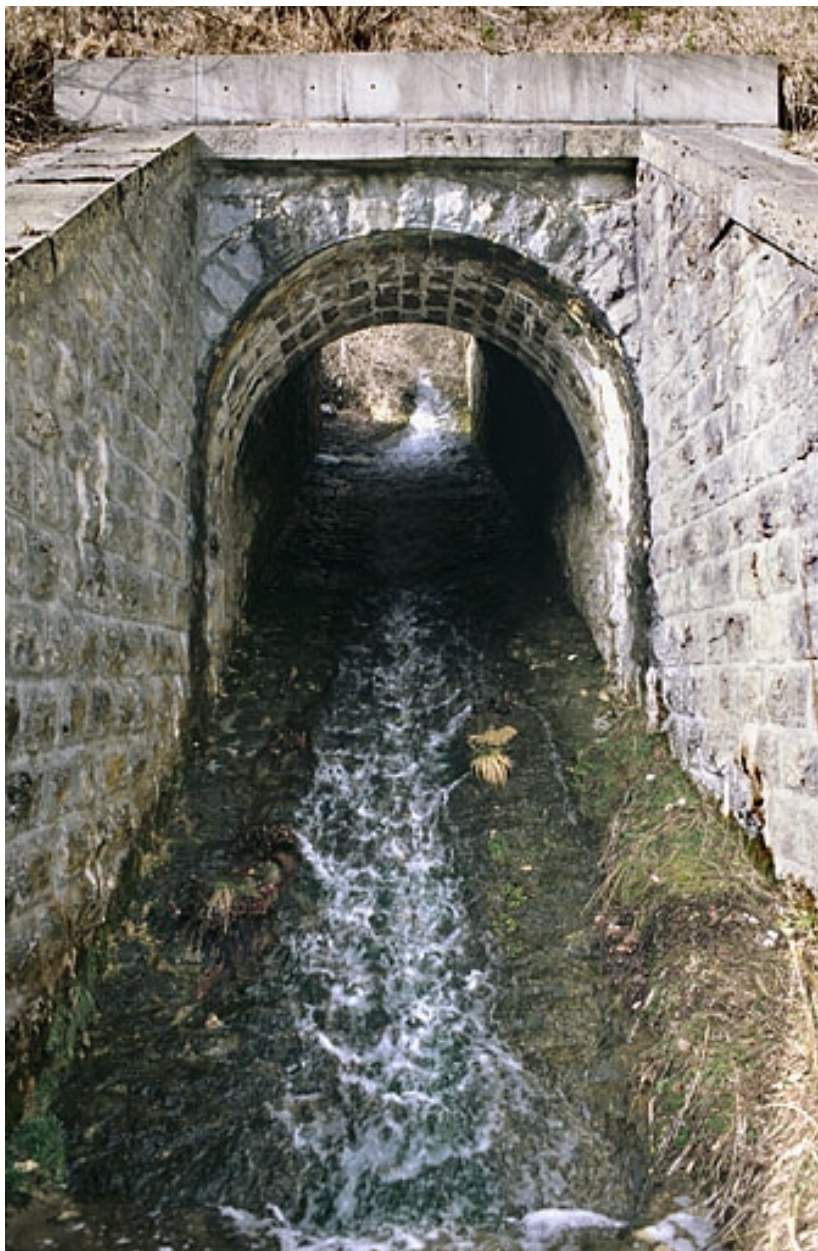
Pont : vue d'ensemble, depuis le sud (aval).
