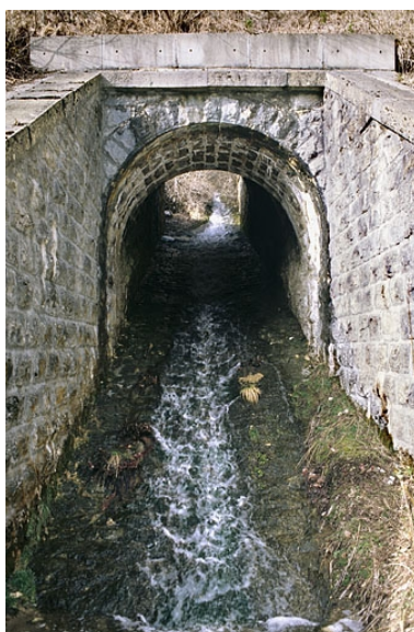
Pont : vue d'ensemble, depuis le sud (aval).
