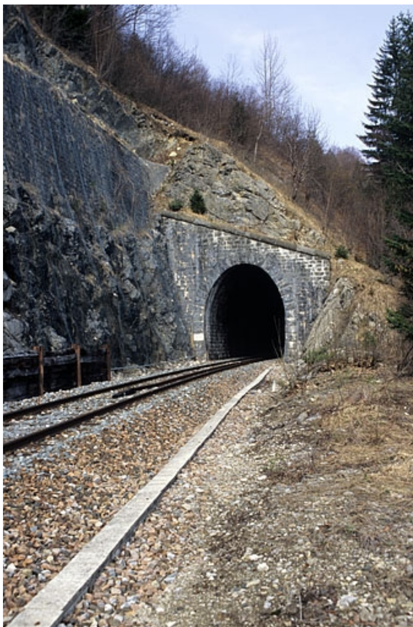
Tunnel : tête sud-ouest (côté La Cluse).
