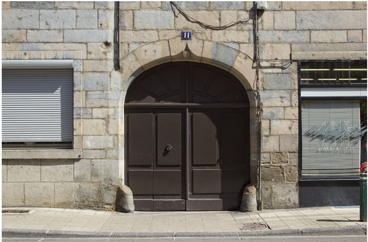
Logis principal : détail du portail d'entrée.
