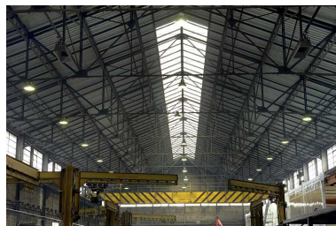
Atelier de fabrication. Charpente et couverture métallique. Phot. Jérôme Mongreville IVR43_20057000490NUCA
