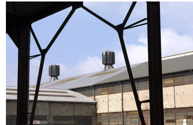
Atelier de fabrication. Cheminées d'extraction. Phot. Jérôme Mongreville IVR43_20067000135NUCA
