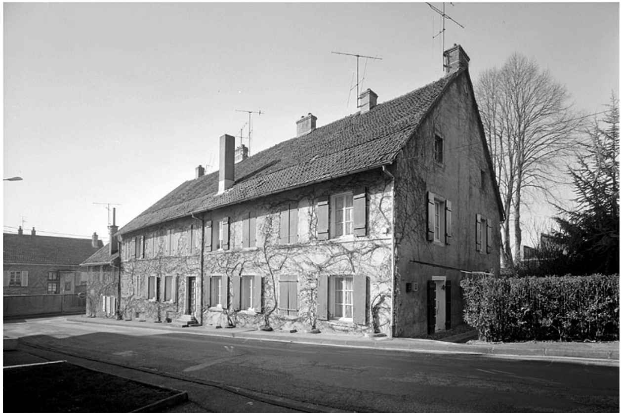
Vue d'ensemble de la façade est.
