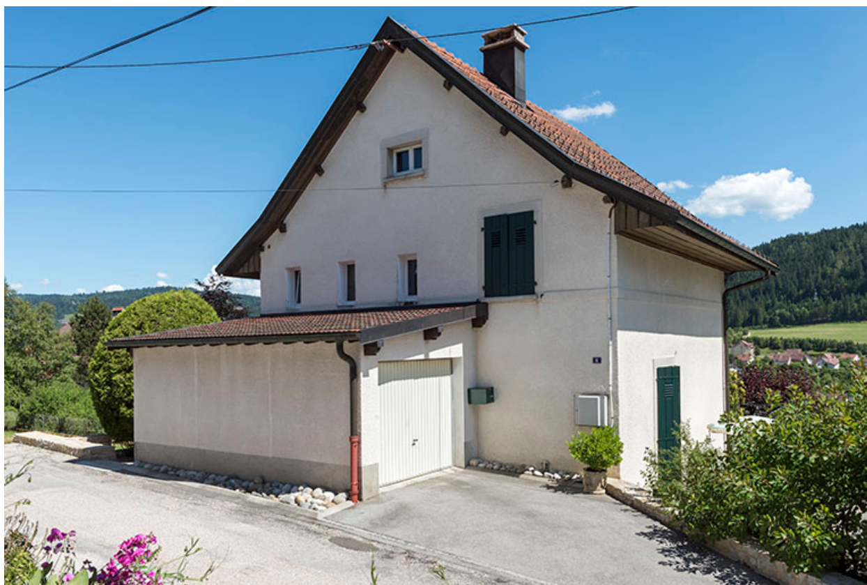
Façades antérieure et latérale droite.
