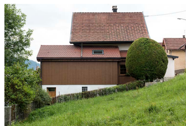
Façade latérale gauche. Phot. Sonia Dourlot IVR43_20162501646NUC4A
