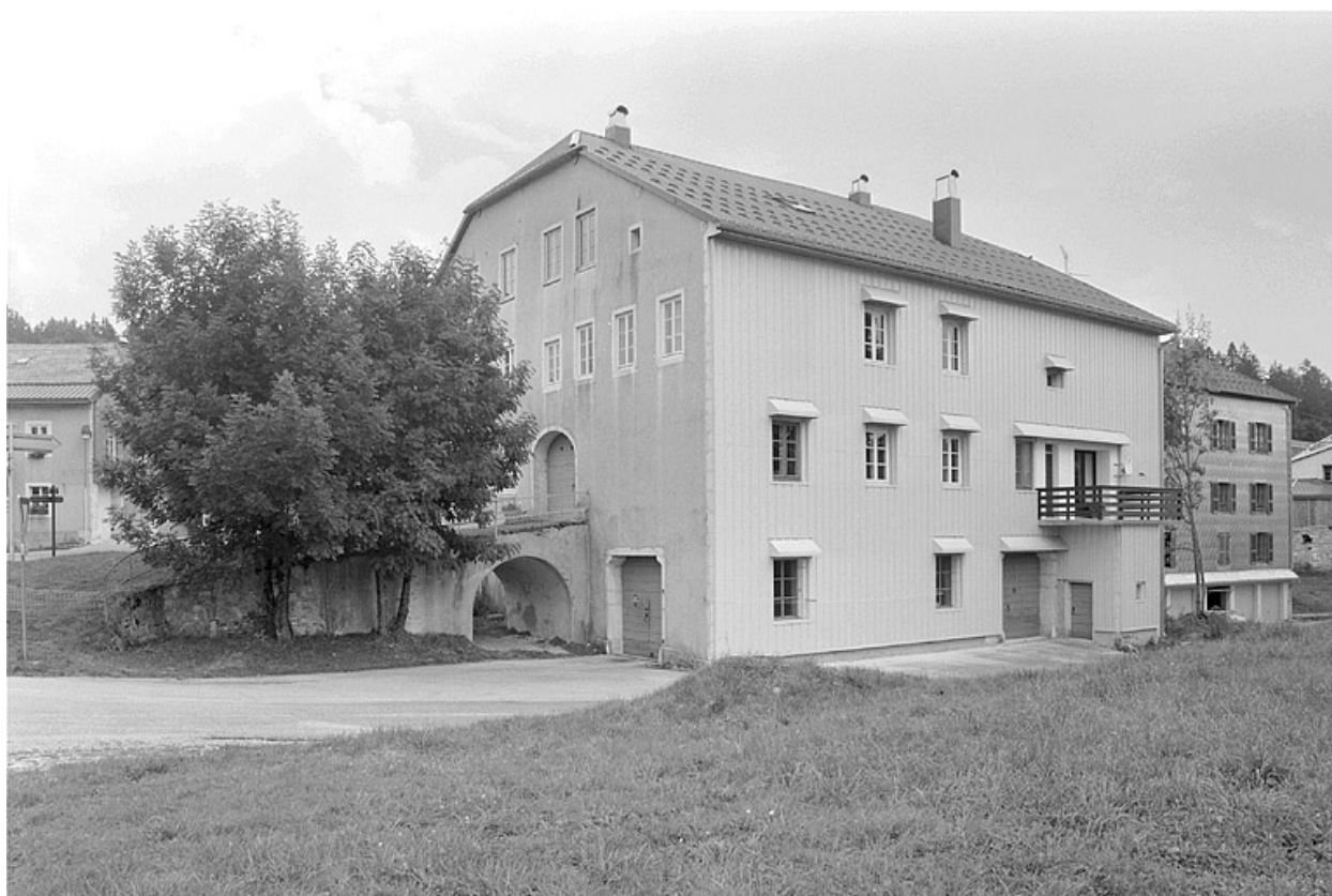
Façade postérieure et face nord-ouest.
