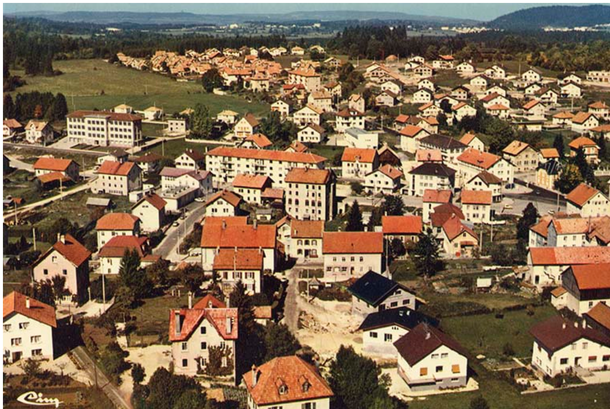
Charquemont (Doubs). Vue aérienne [quartier de la gare, de la Rue Neuve et des Cités, vu depuis le sud], entre 1968 et 1975. Le premier bâtiment de l'usine est construit.
