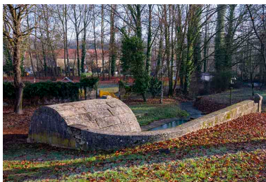
Mur de soutènement, vue depuis le nord. Phot. Jérôme Mongreville IVR43_20197000142NUC4A
