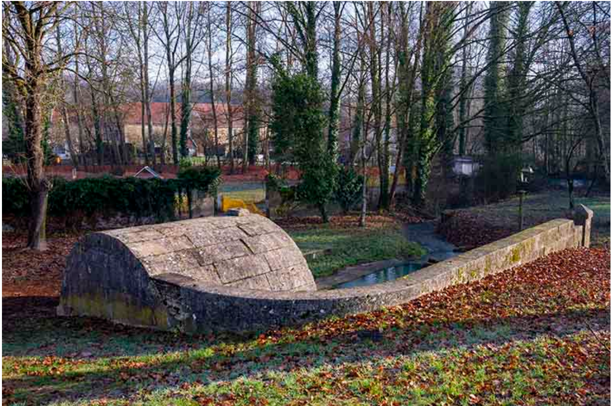
Mur de soutènement, vue depuis le nord.
