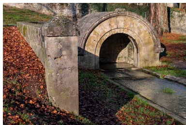
Mur de soutènement, vue depuis le sud. Phot. Jérôme Mongreville IVR43_20197000143NUC4A
