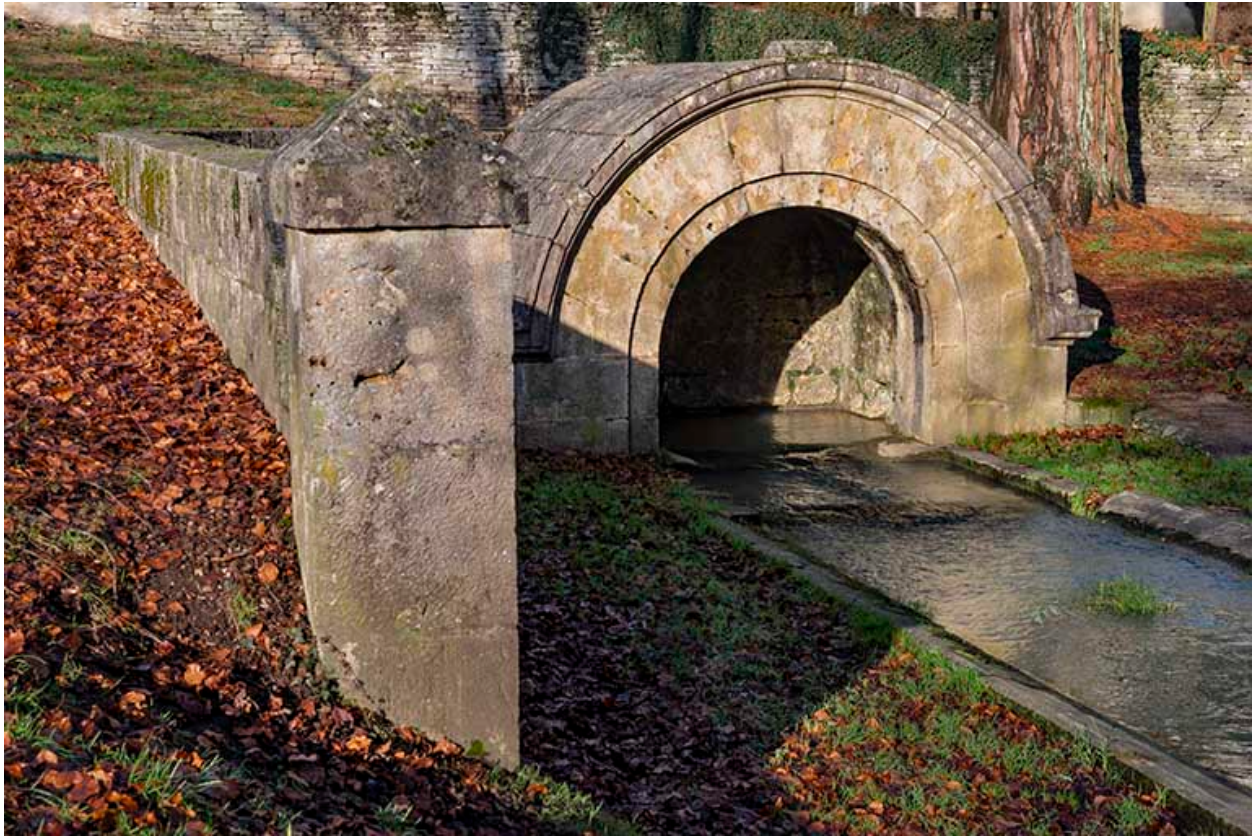
Mur de soutènement, vue depuis le sud.
