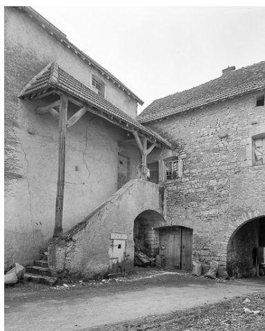
Vue de l'escalier extérieur. Phot. Yves Sancey IVR43_19827000474V
