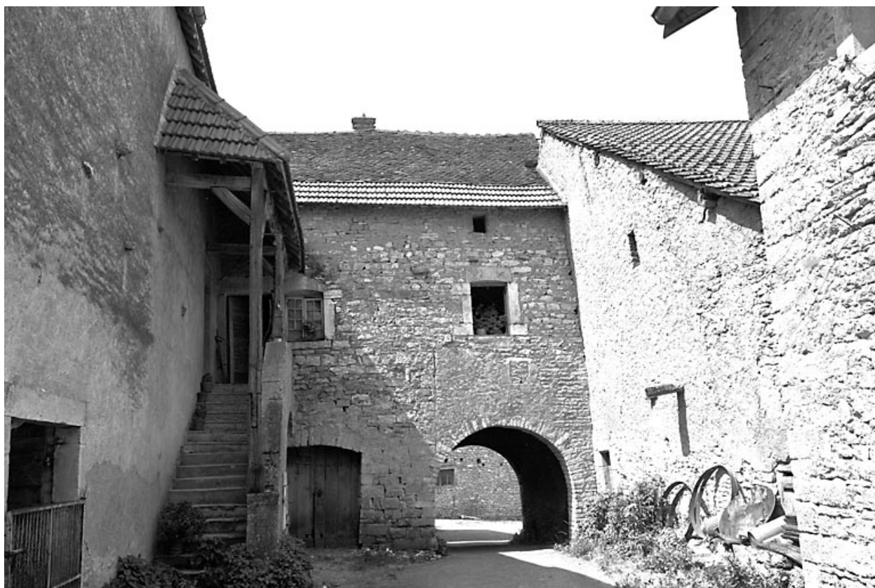
Façade sur cour.
