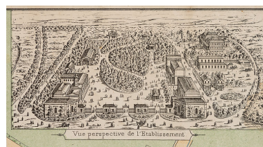
Vue d'ensemble (vers 1895-1896). Repro. Pierre-Marie Barbe- Richaud, Autr. auteur inconnu IVR26_20205800331NUC2A
