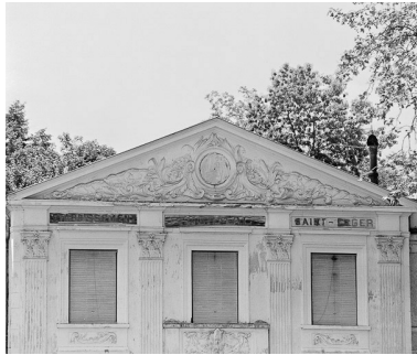
Façade antérieure, avant-corps, détail, fronton. Phot. Michel Thierry IVR26_19845800008X
