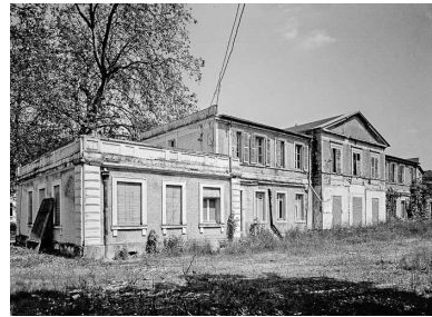
Façade postérieure, vue prise en 1984. Phot. Jean-Luc Duthu IVR26_19845800013V
