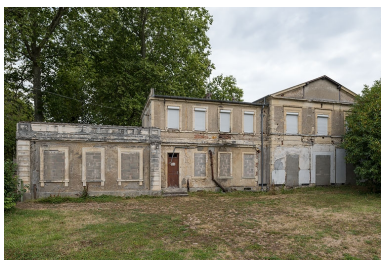
Façade postérieure, vue prise en 2020. Phot. Pierre-Marie Barbe-Richaud IVR26_20205800628NUC4A
