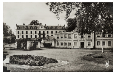
Vue de l'établissement thermal quelques années avant sa fermeture. Phot. Pierre-Marie Barbe- Richaud, Autr. auteur inconnu IVR26_20205800011NUC4A
