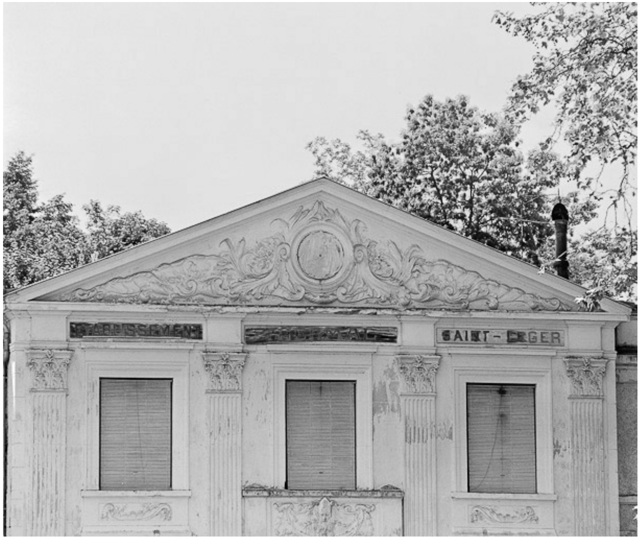
Façade antérieure, avant-corps, détail, fronton.
