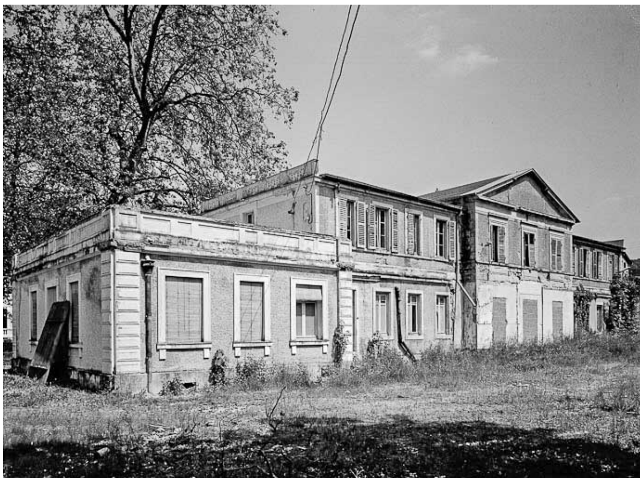
Façade postérieure, vue prise en 1984.
