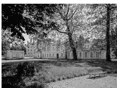
Façade antérieure. Phot. Jean-Luc Duthu IVR26_19845800012V
