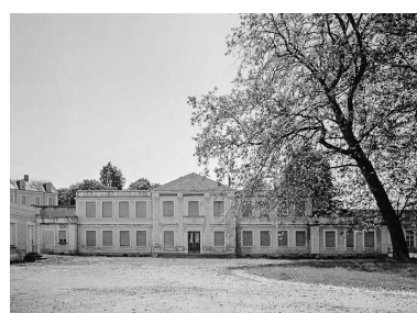
Façade antérieure. Phot. Jean-Luc Duthu IVR26_19845800006V
