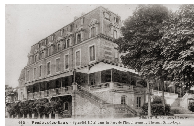
Façade nord. Autr. auteur inconnu IVR26_20195800762NUC4A
