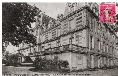
Façade ouest. Autr. auteur inconnu IVR26_20195800761NUC4A
