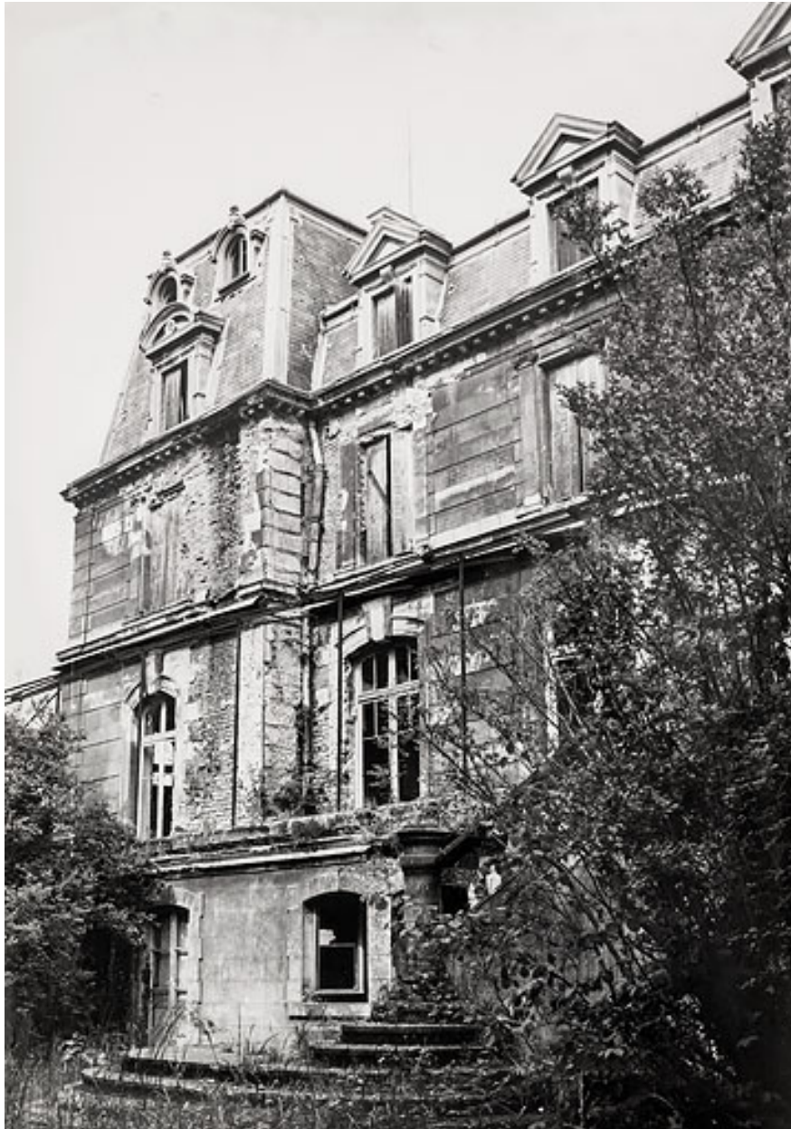
Vestiges de l'hôtel avant sa destruction.
