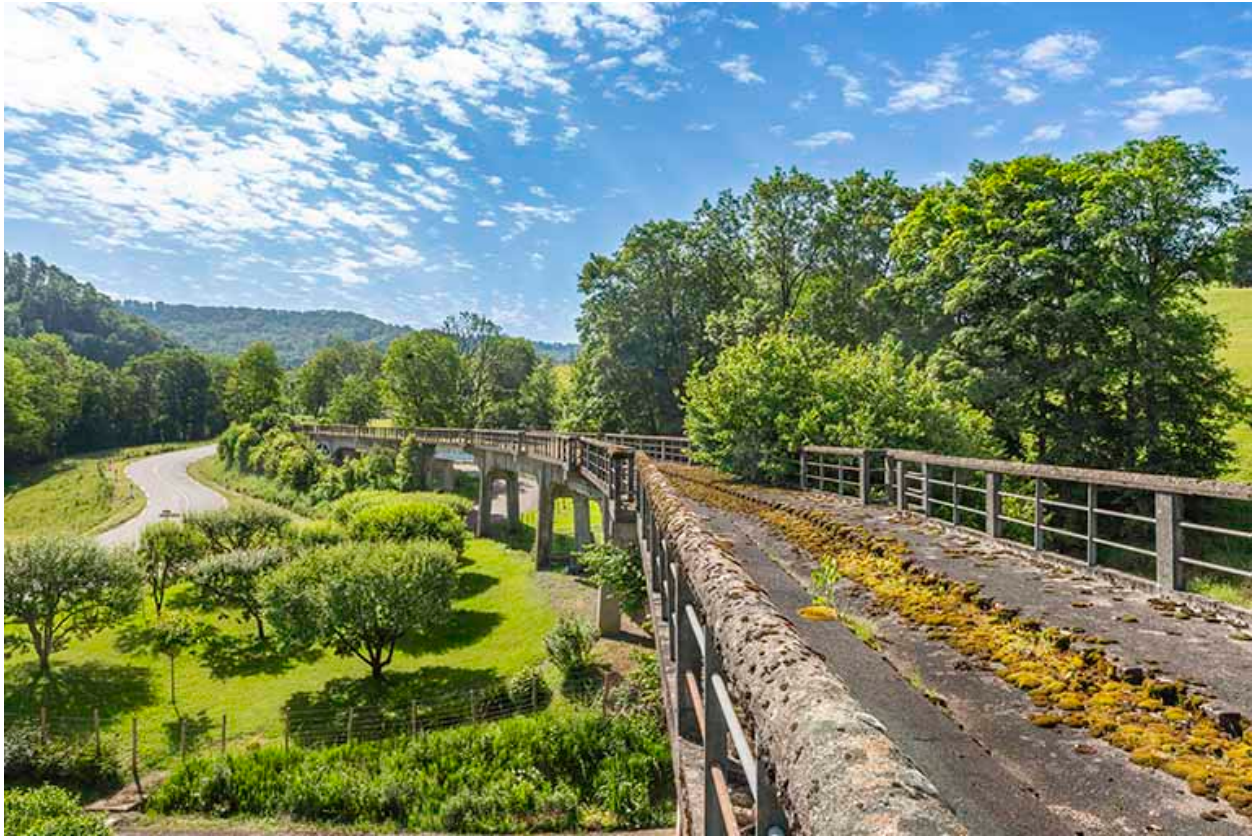
Viaduc du Martinet du Haut.
