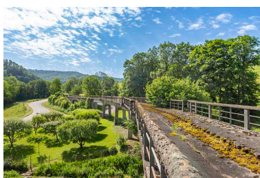
Viaduc du Martinet du Haut.
