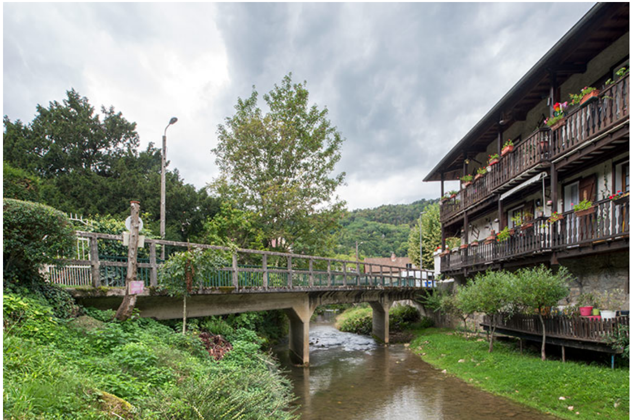
Vue amont du pont franchissant la Furieuse au sud de la place Aubarède.
