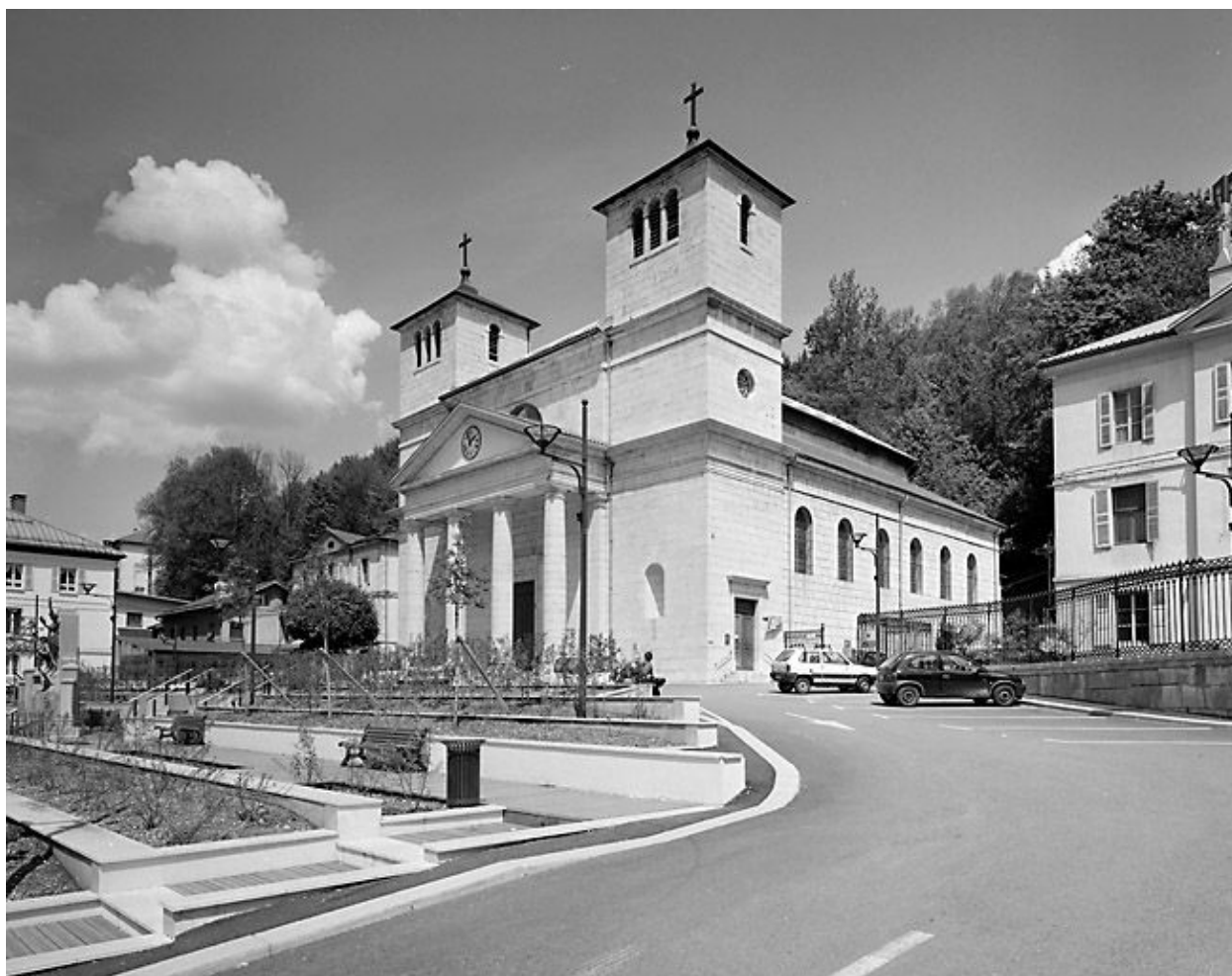
Vue d'ensemble rapprochée, côté est : église.
