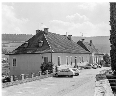
Grand'Combe-Château : presbytère. Phot. Dominique Humbert IVR43_19762500698X
