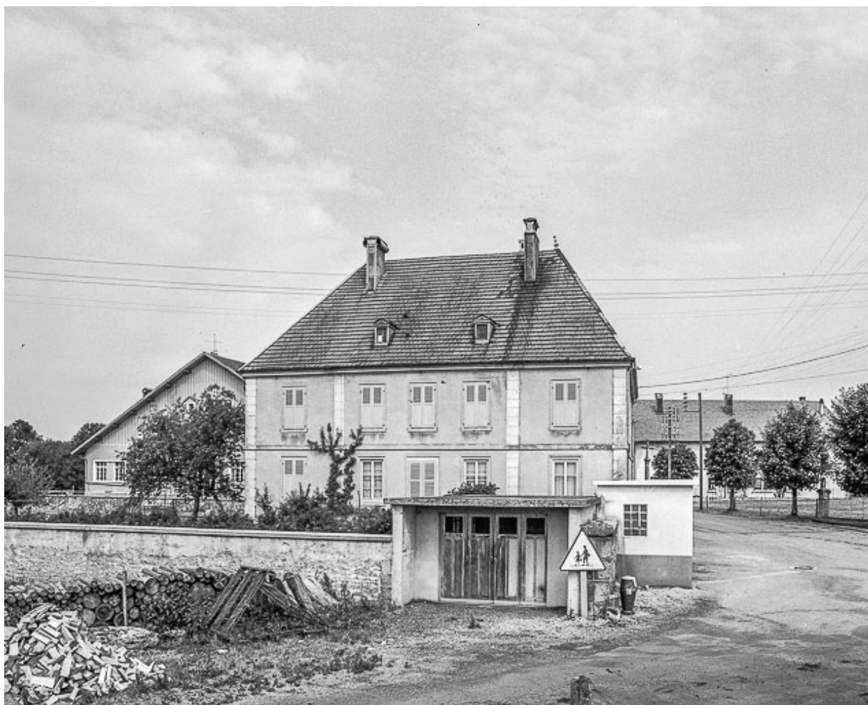
Les Combes, lieu-dit La Motte : presbytère.
