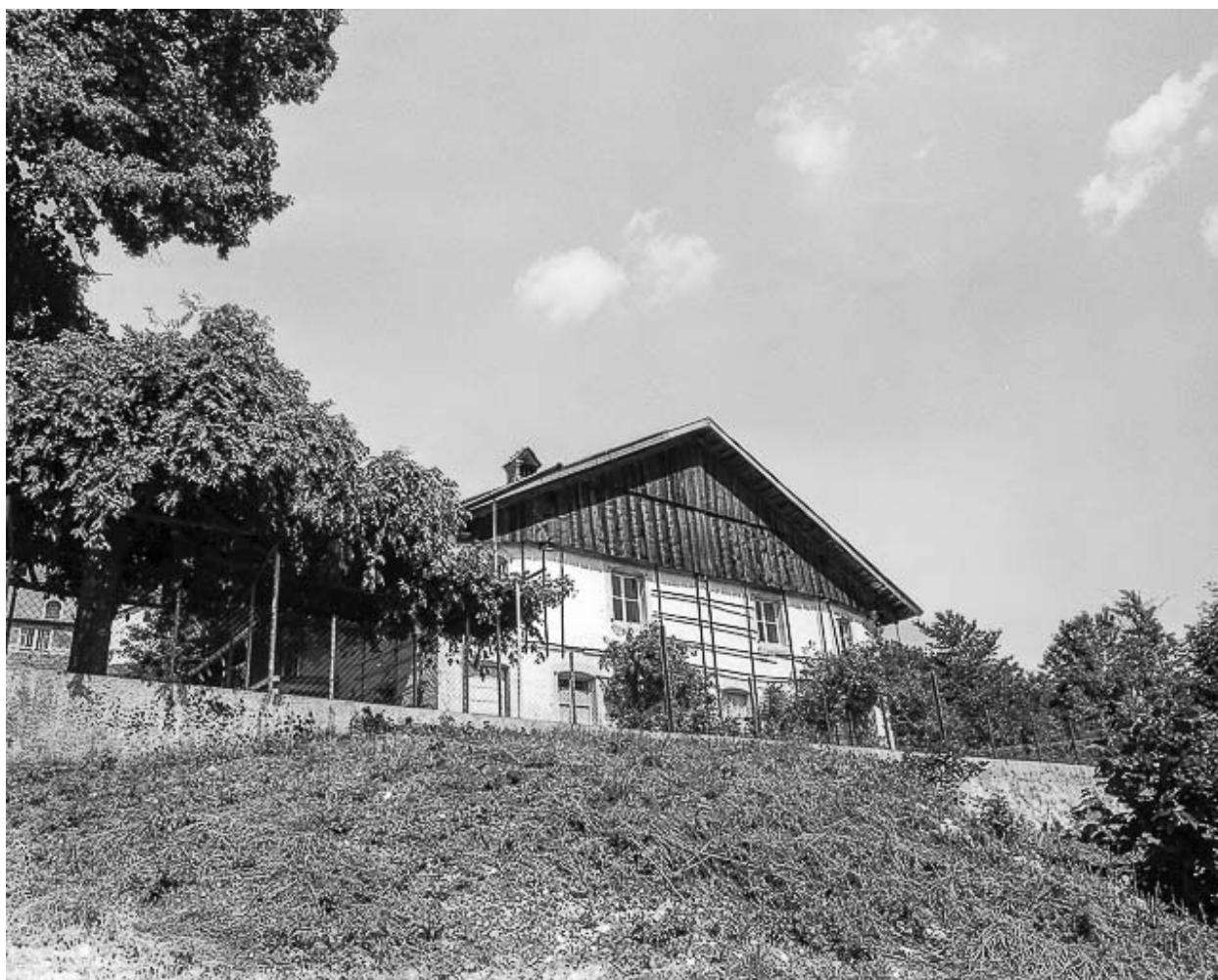
Villers-le-Lac, lieu-dit Le Pissoux : presbytère.
