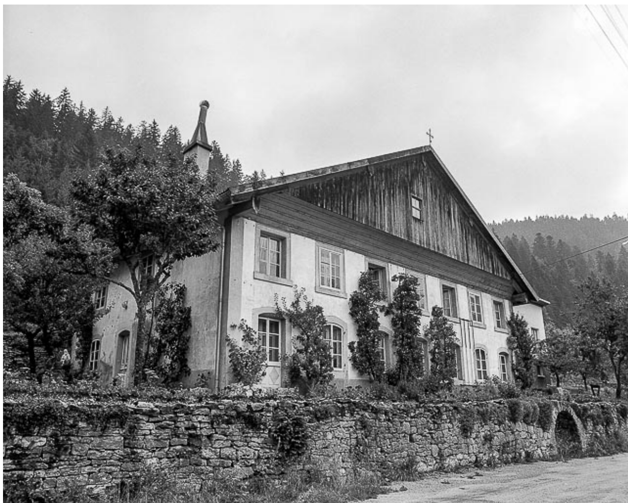
Montlebon, lieu-dit Derrière le Mont : presbytère.
