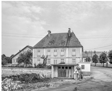
Les Combes, lieu-dit La Motte : presbytère. Phot. Dominique Humbert IVR43_19762500155X
