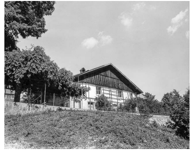
Villers-le-Lac, lieu-dit Le Pissoux : presbytère. Phot. Dominique Humbert IVR43_19762500430X
