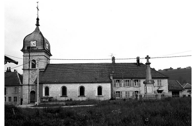
Les Combes, lieu-dit Remonot : presbytère. Phot. Yves Sancey IVR43_19752500647X
