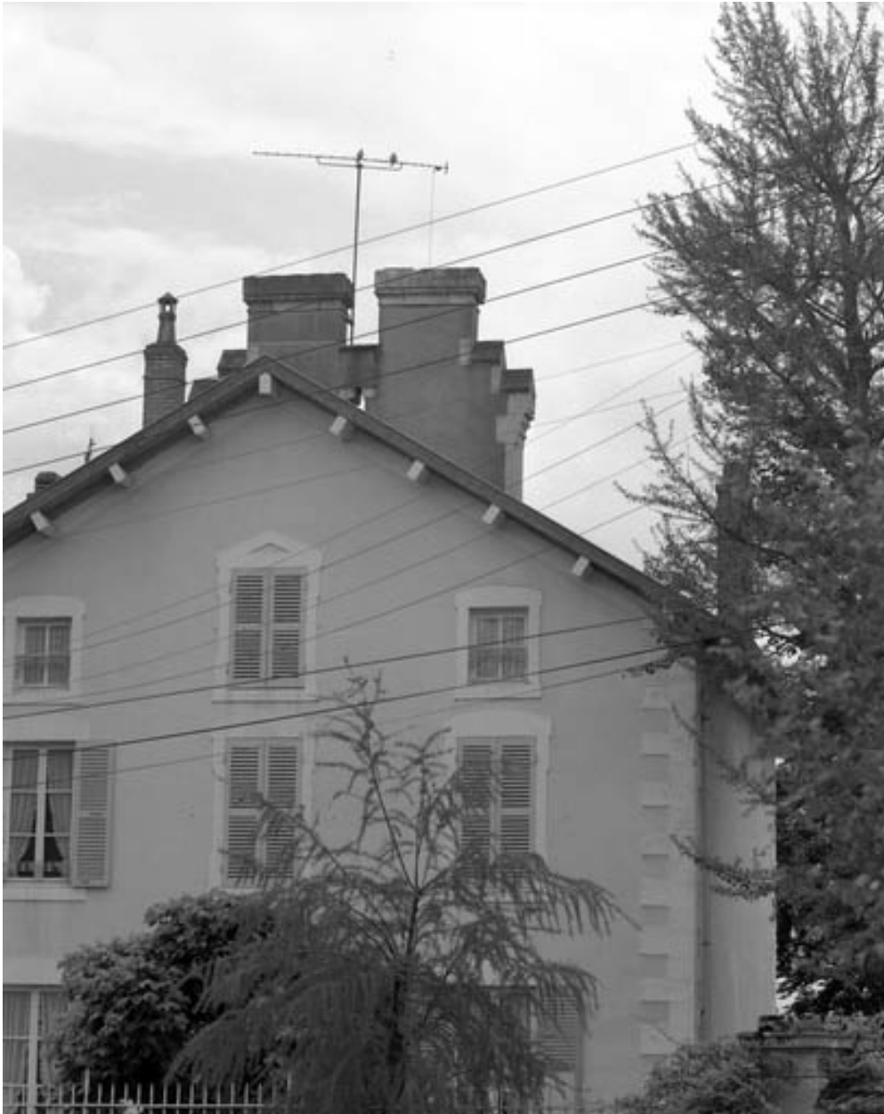
Détail de la façade antérieure sur pignon.
