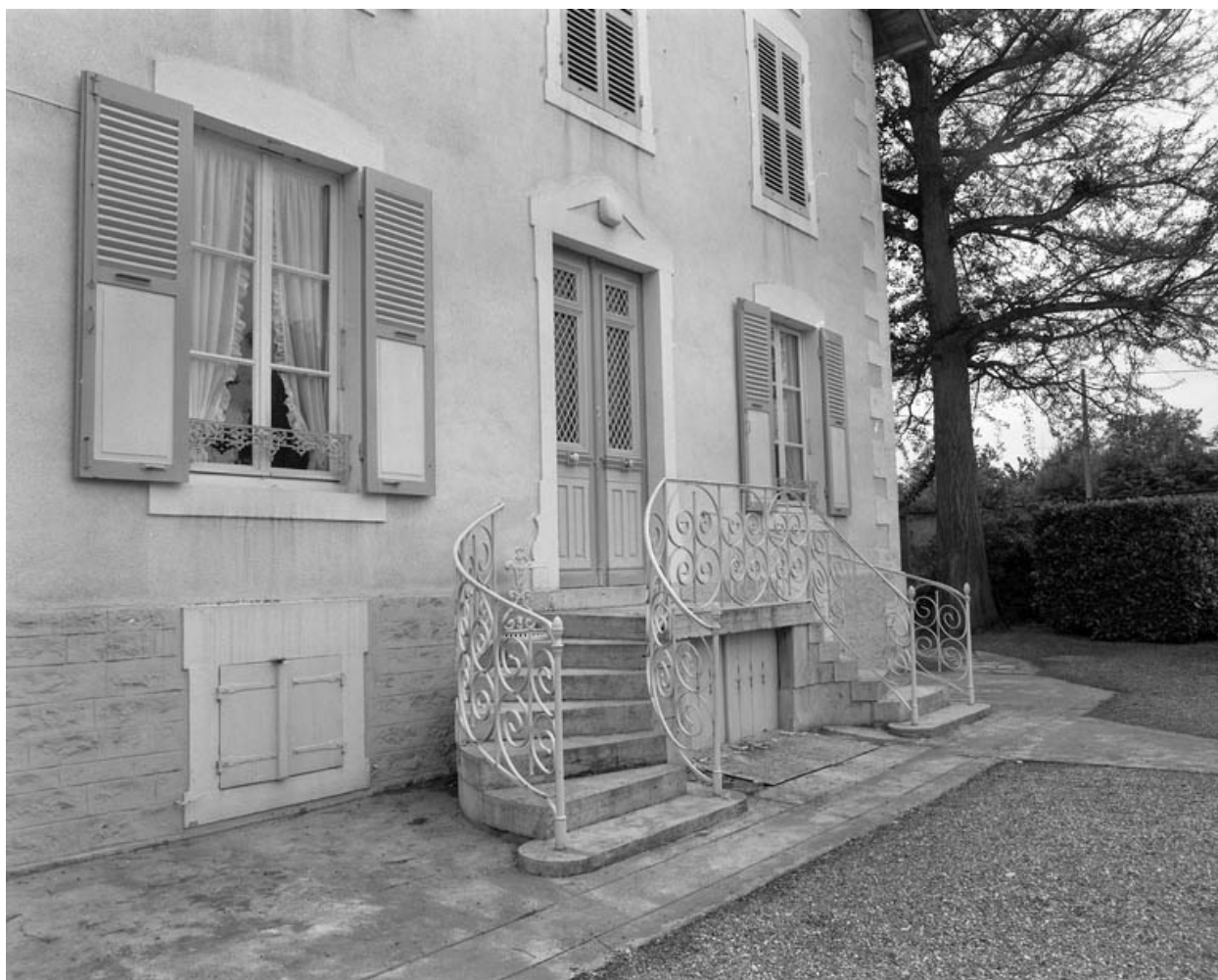
Détail du perron de l'habitation.
