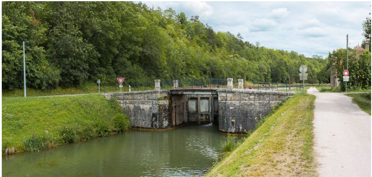
Vue d'ensemble, d'aval.
