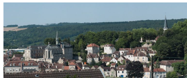
Vue d'ensemble. Phot. Pierre-Marie Barbe-Richaud IVR26_20122101917NUC4AQ
