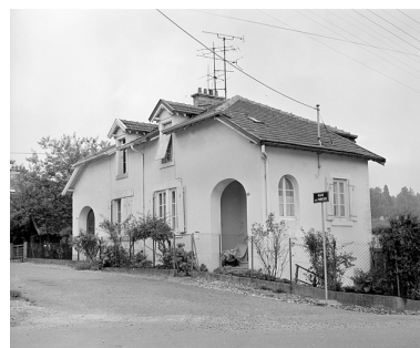
Maison jumelée rue des Fondateurs.SRI. Enquête régionale sur les bâtiments industriels (1979-1981). Phot. Yves Sancey IVR43_19819000091X
