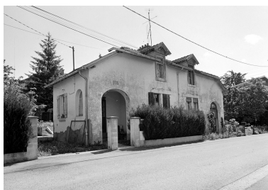
Maison jumelée rue des Fondateurs. Phot. Yves Sancey IVR43_20029000358X
