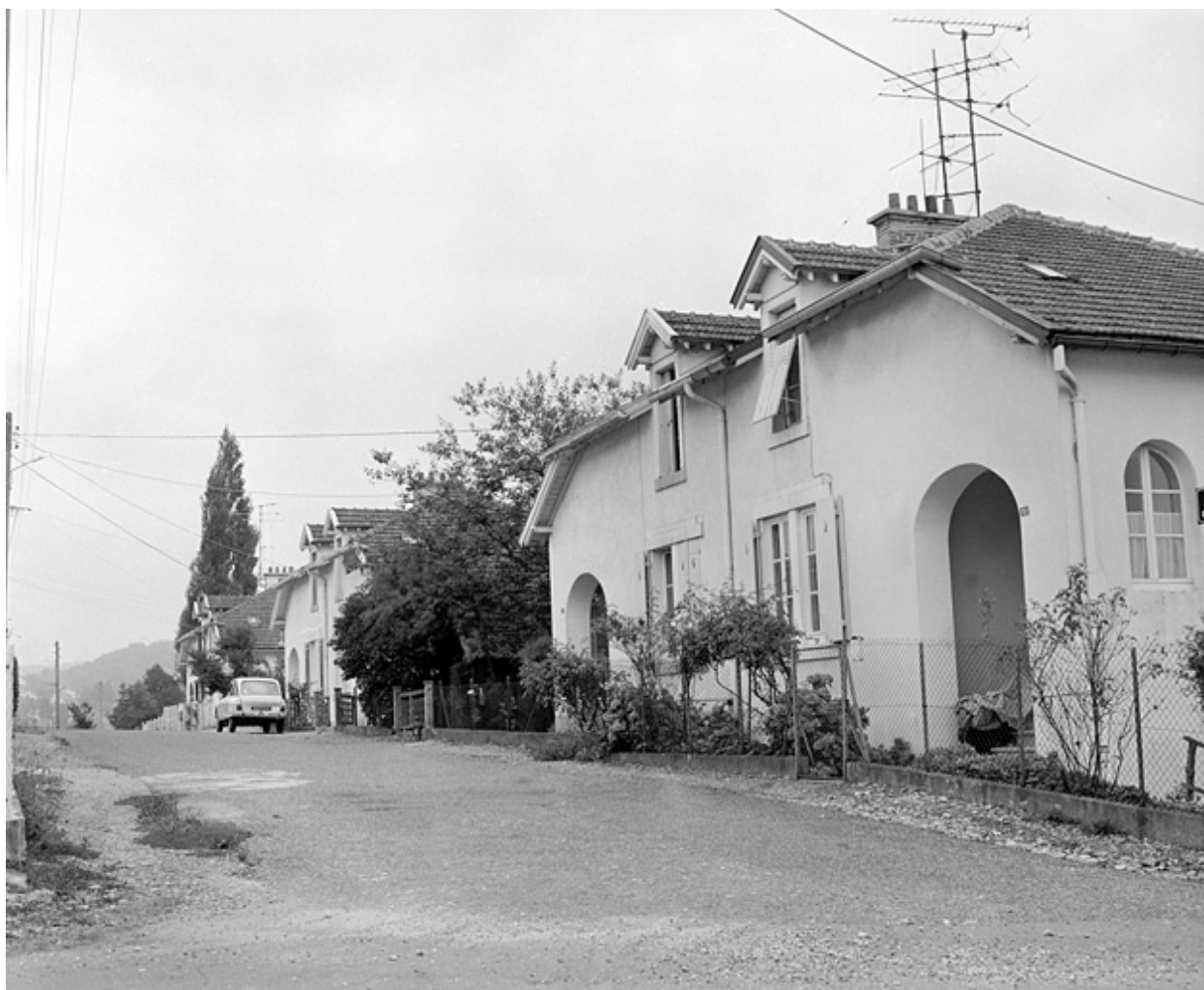
Vue de la rue des Fondateurs.SRI. Enquête régionale sur les bâtiments industriels (1979-1981).
