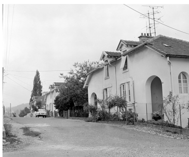
Vue de la rue des Fondateurs.SRI. Enquête régionale sur les bâtiments industriels (1979-1981). Phot. Yves Sancey IVR43_19819000090X
