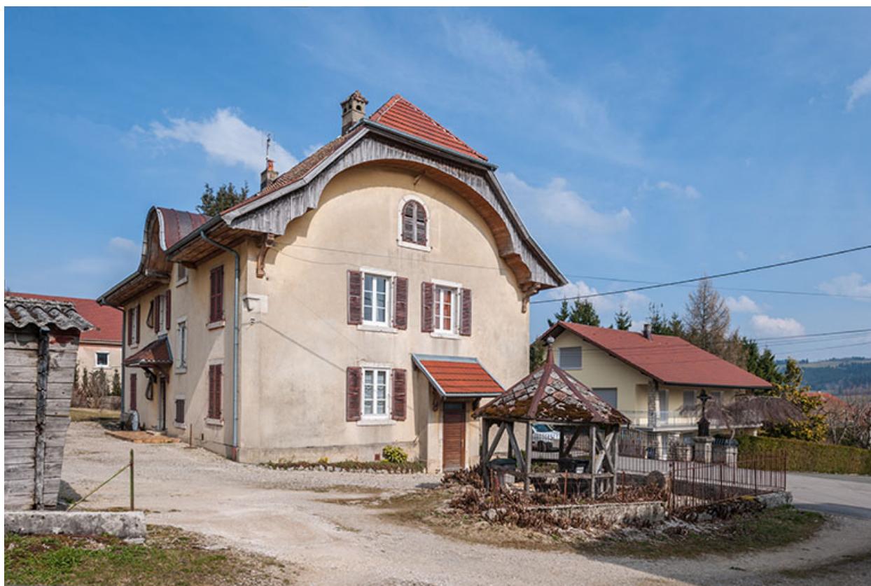
Logement patronal : façades postérieure et latérale gauche.
