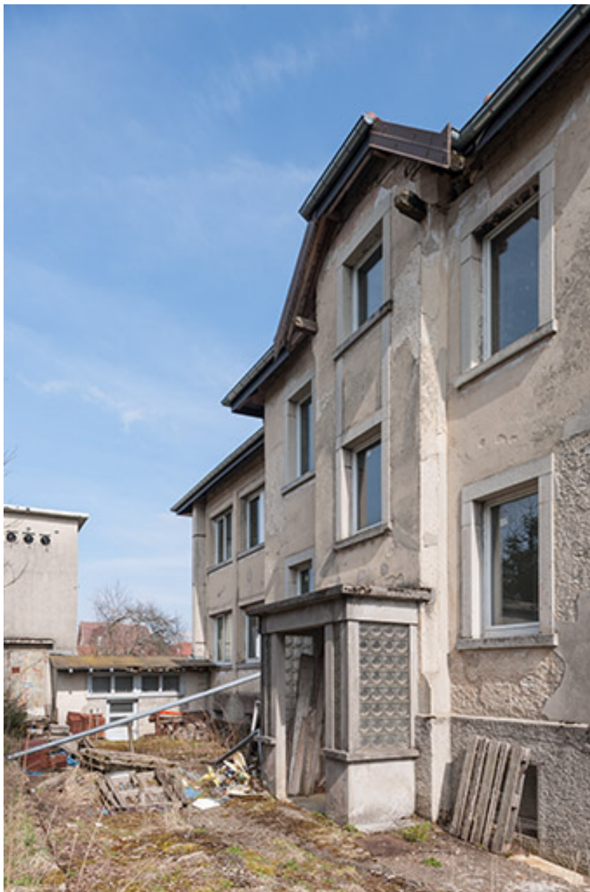
Usine : façade postérieure, de trois quarts droite.
