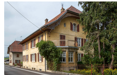
Logement patronal, de trois quarts droite. Phot. Yves Sancey IVR43_20122502250NUC2A
