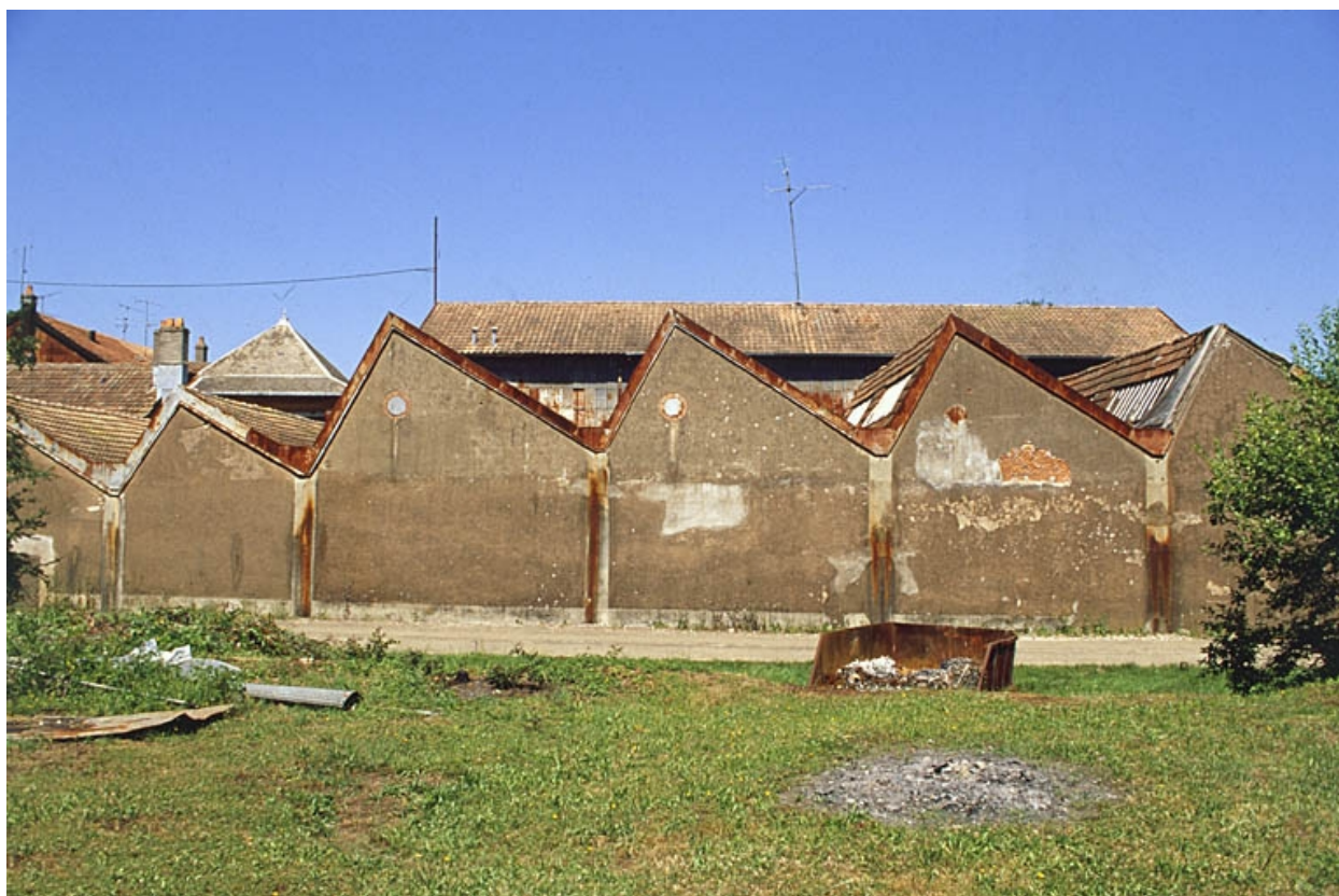
Pignons des sheds au sud.
