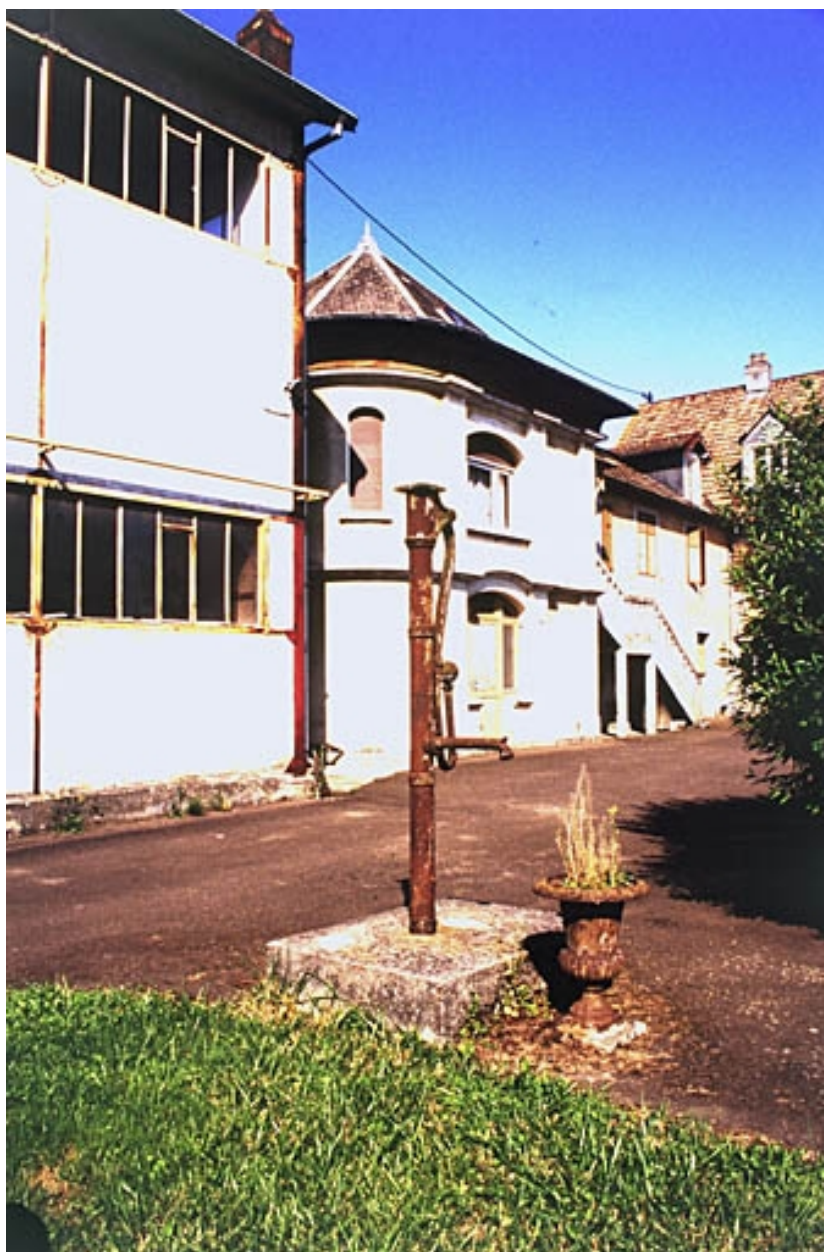
Atelier et logement depuis l'est.
